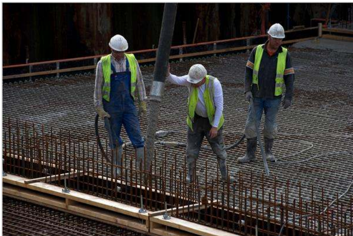
Figuur 654.1 - Betonstort
