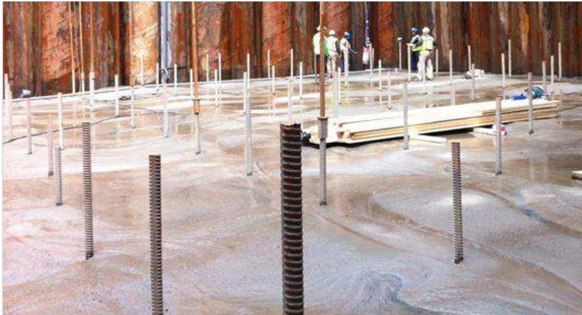
Figuur 638.1 - Onderwaterbetonvloer in bouwkuip
