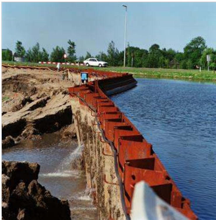
Figuur 134.1 - Bezijken van de passieve zijde tijdens de ontgraving van de bouwput voor de bouw van het Gaag-aquaduct [ https://beeldbank.rws.nl , Rijkswaterstaat / Rens Jacobs]
