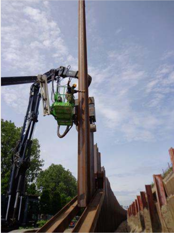
Figuur 541.1 - Voorbeeld aanbrengen van damwanden
