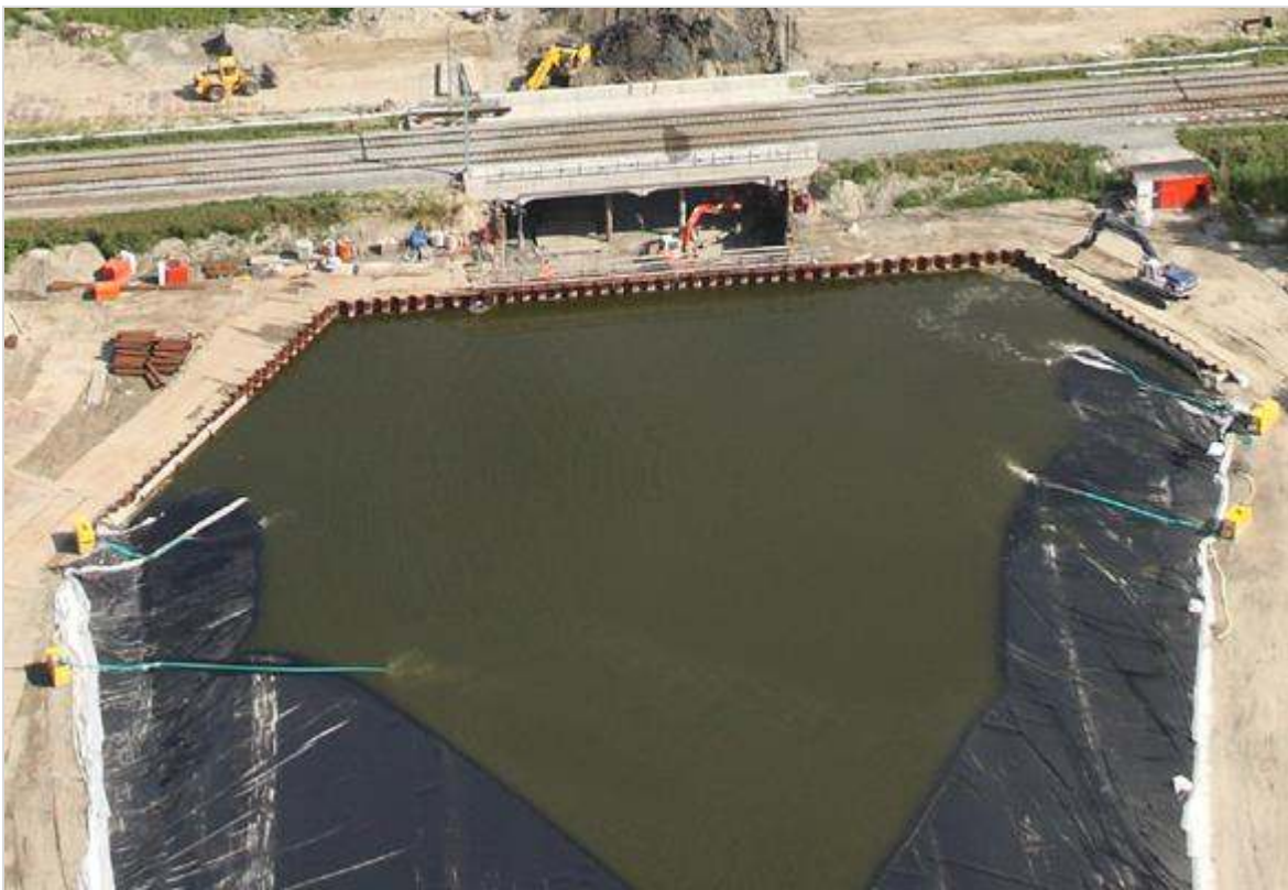
Figuur 588.1 - Afzinken folieconstructie
