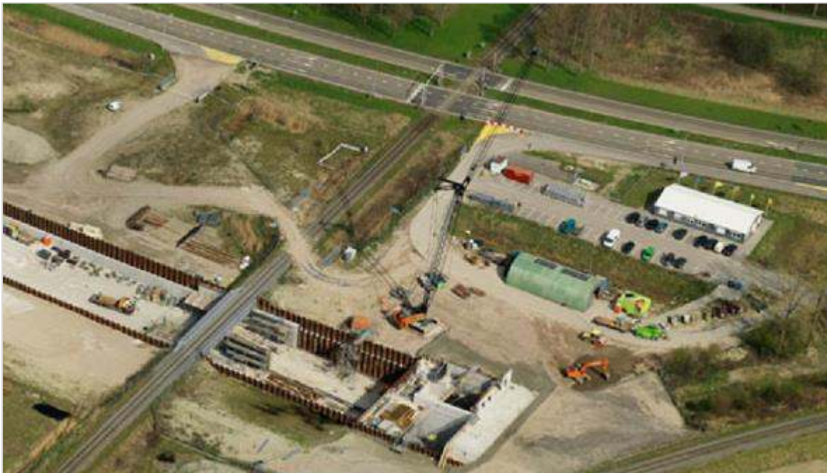
Figuur 523.1 - Voorbeeld inrichting bouwplaats
