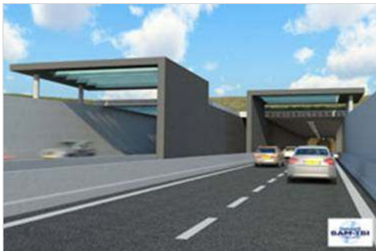
Figuur 505.1 - Tegenlichtschermen Sluiskiltunnel; Hier zijn om architectonische redenen aan de oostkant de tegenlichtschermen zowel bij de ingang als de uitgang aangebracht.
