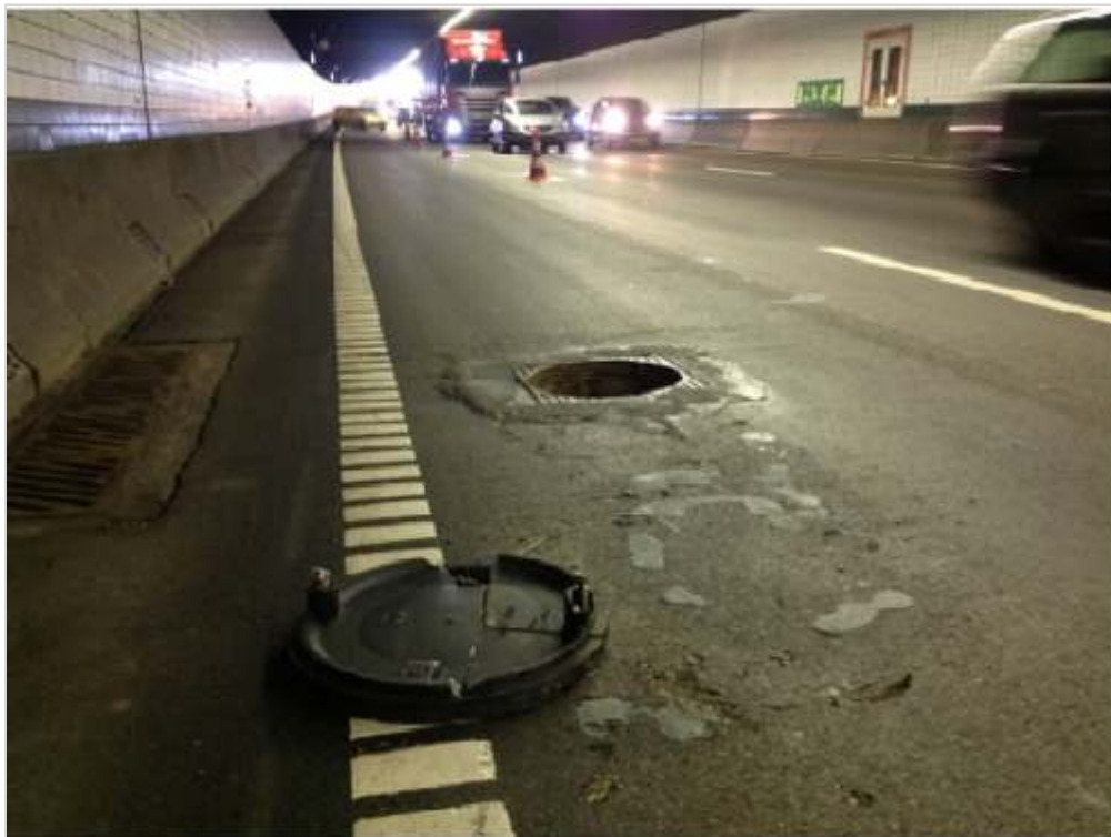
Figuur 385.1 - Losgereden putdeksel boven de middenkelder van de Zeeburgertunnel
