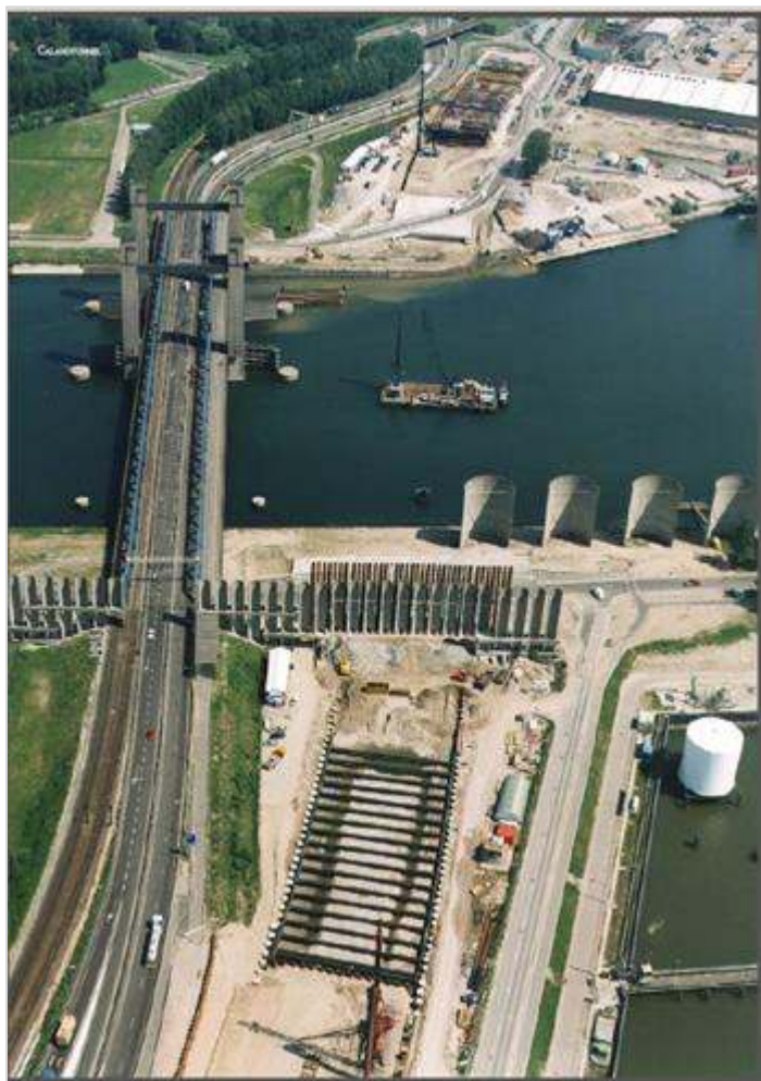
Figuur 126.1 - Bouwput Thomassentunnel
