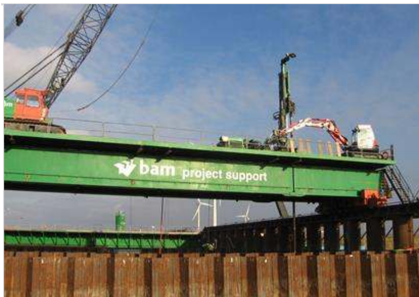
Figuur 623.2 - Inbrengen van GEWI palen vanaf traverse
