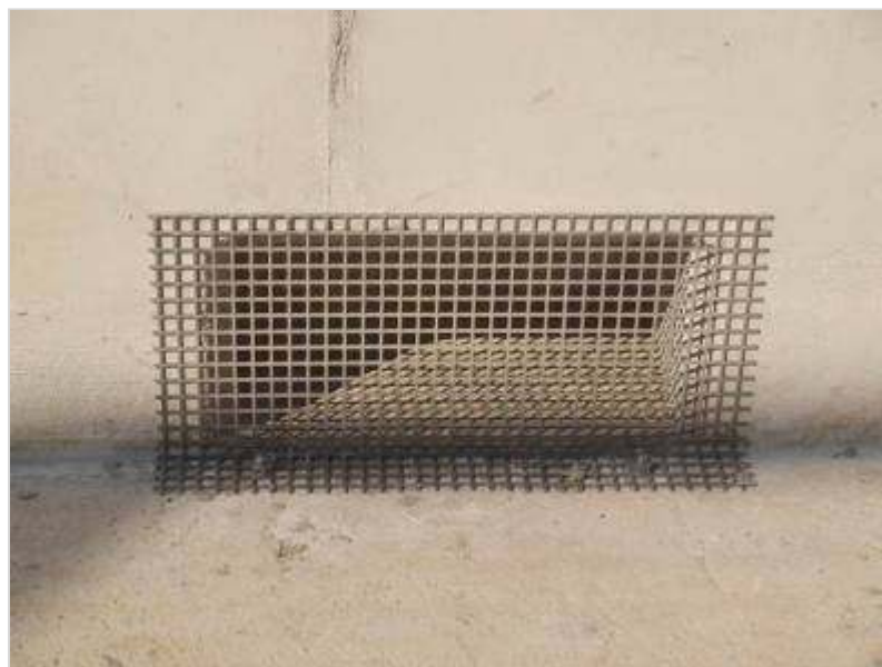
Figuur 398.2 - Rooster voor doorvoeropening in ballastbed
