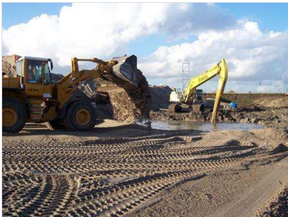
Figuur 596.1 - Droog ontgraven
