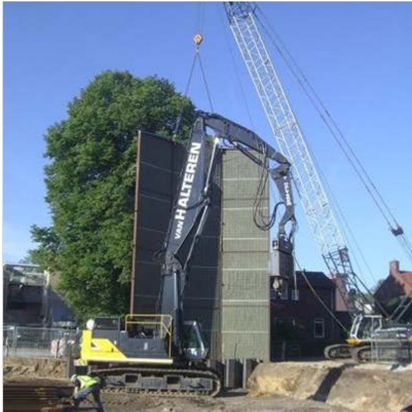
Figuur 143.1 - Mobiel geluidsscherm bij bouw Combitunnel Nijverdal
