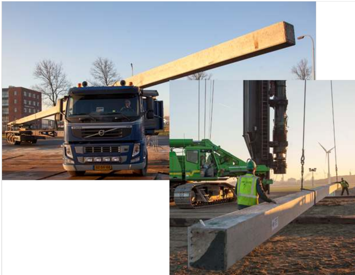
Figuur 622.1 - Transport en hijsen van prefab paal
