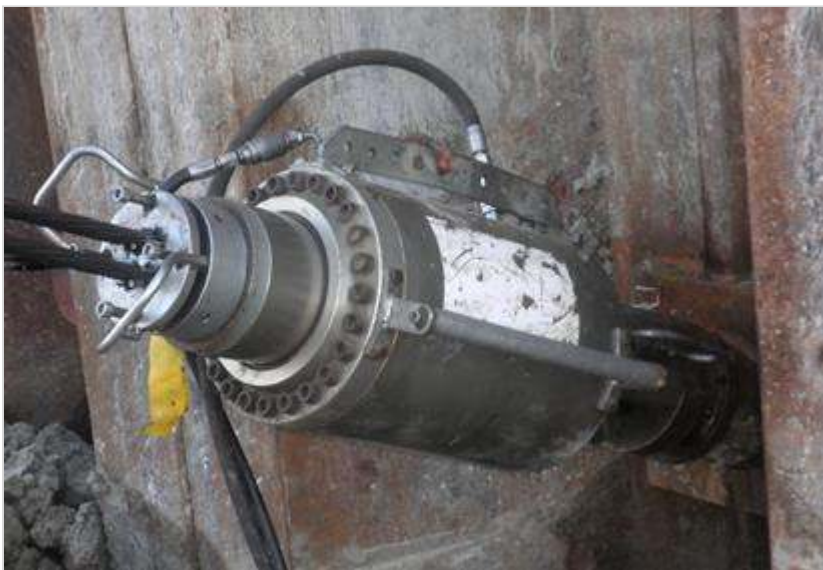
Figuur 576.1 - Testen groutanker
