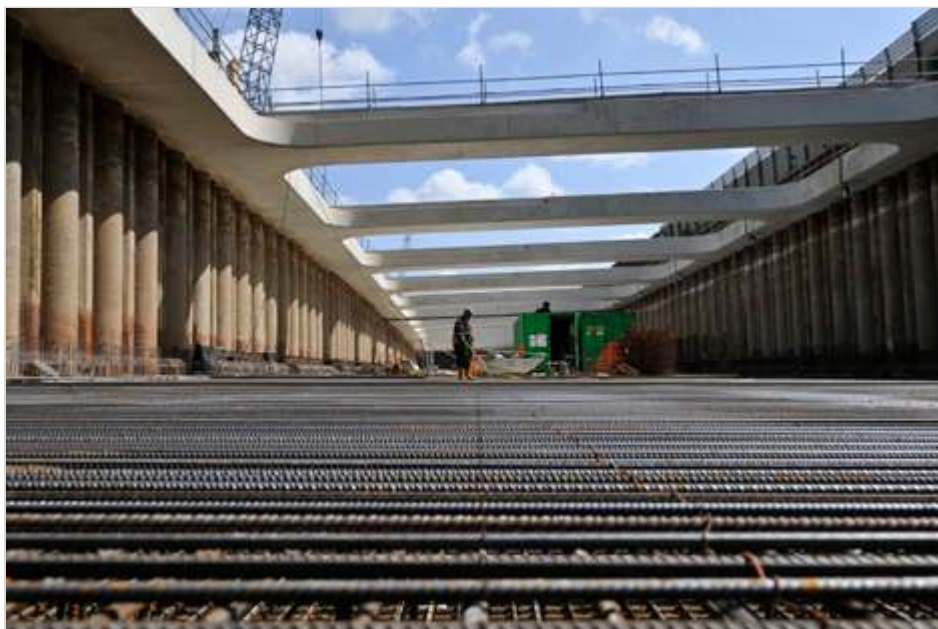
Figuur 73.1 - Permanente stempels bij verdiepte ligging A4 te Leiderdorp (bouwfase)
