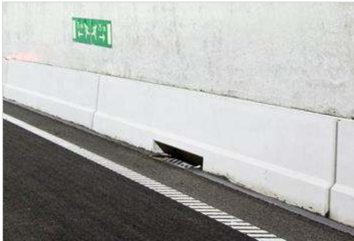
Figuur 387.1 - Inlaatput 2e Coentunnel met ribbelstreep 50-50 mm
