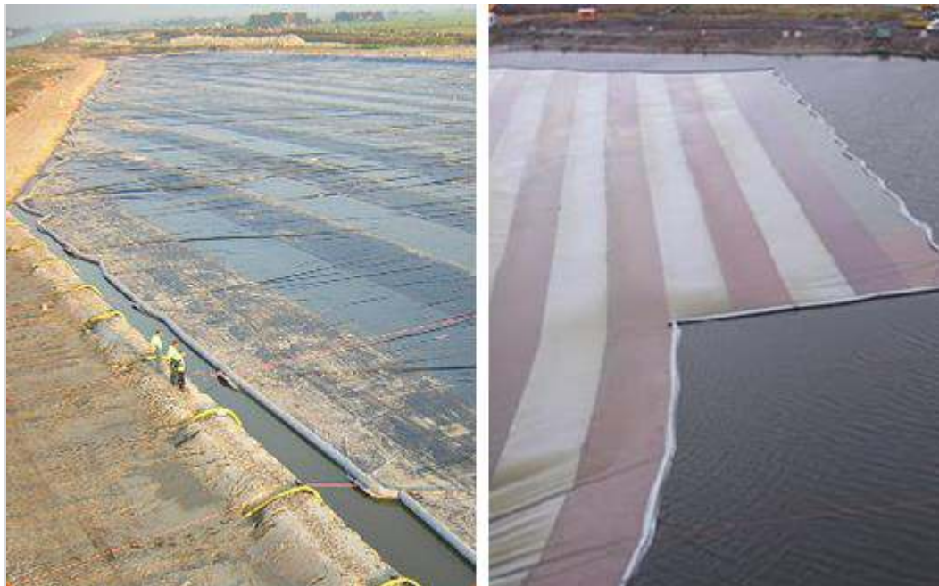
Figuur 193.1 - Afzinken folieconstructie met behulp van drijvers
