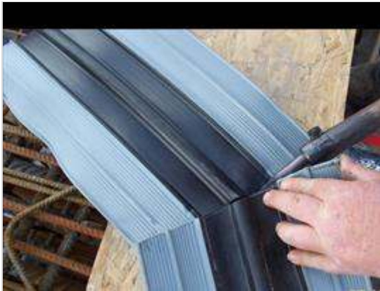
Figuur 93.4 - Voorbeeld van lassen van een PVC voegenband met een hete lucht föhn
