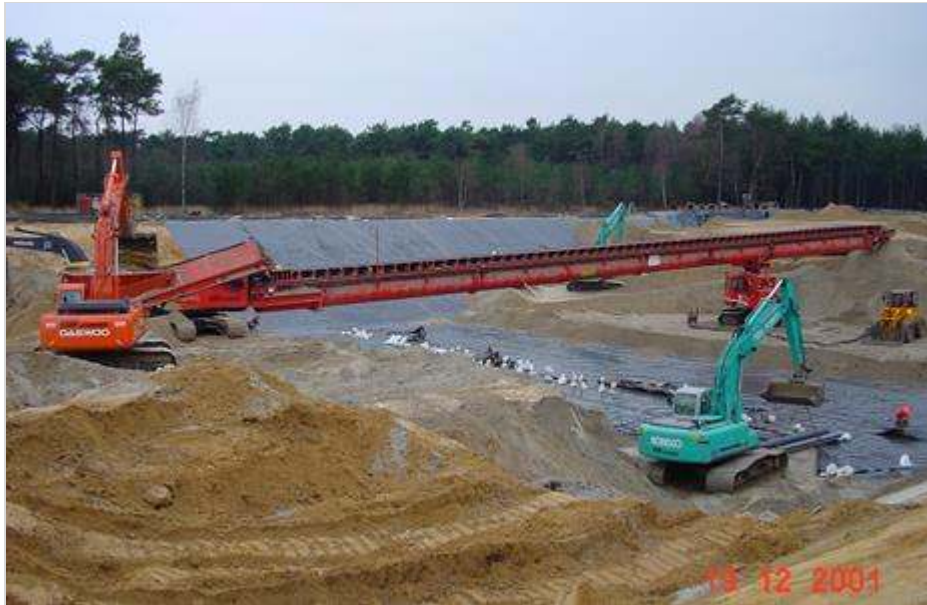
Figuur 188.3 - Afdekken folieconstructie
