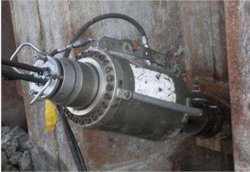
Figuur 576.1 - Testen groutanker
