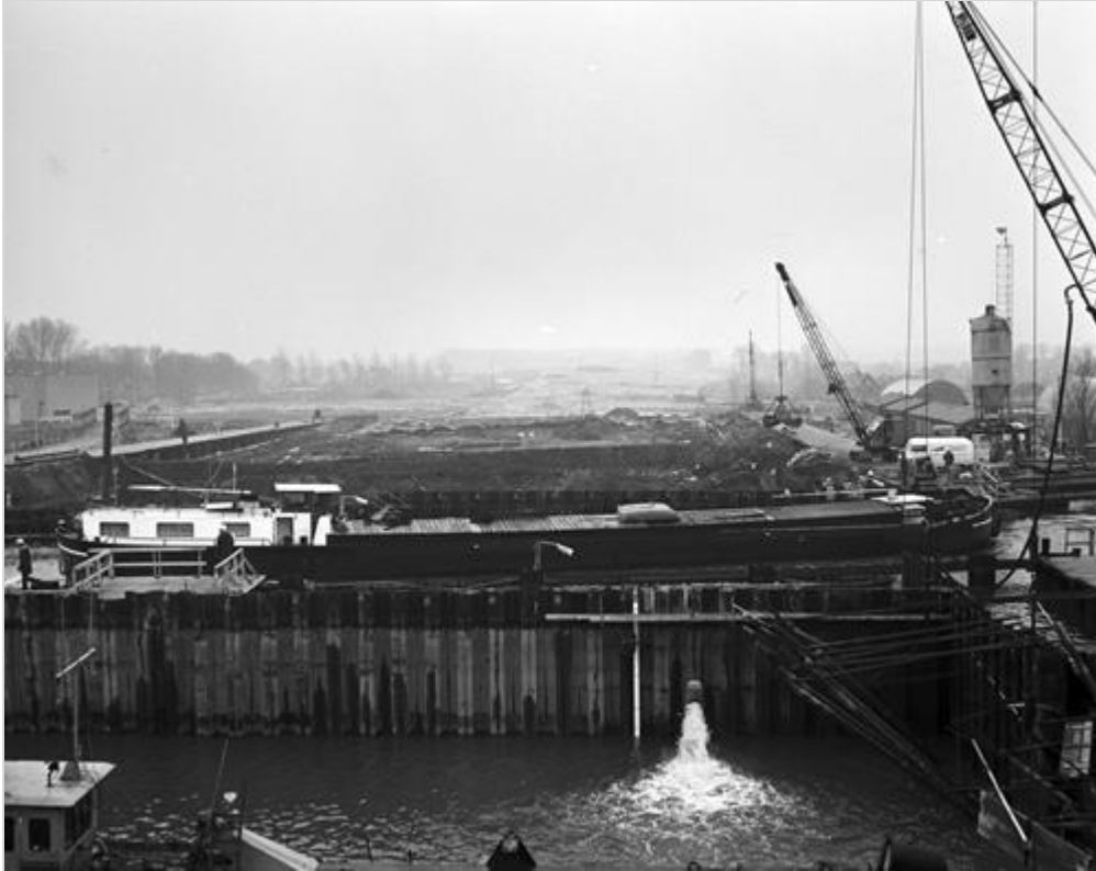
Figuur 213.4 - Bouw van Gouweaquaduct
