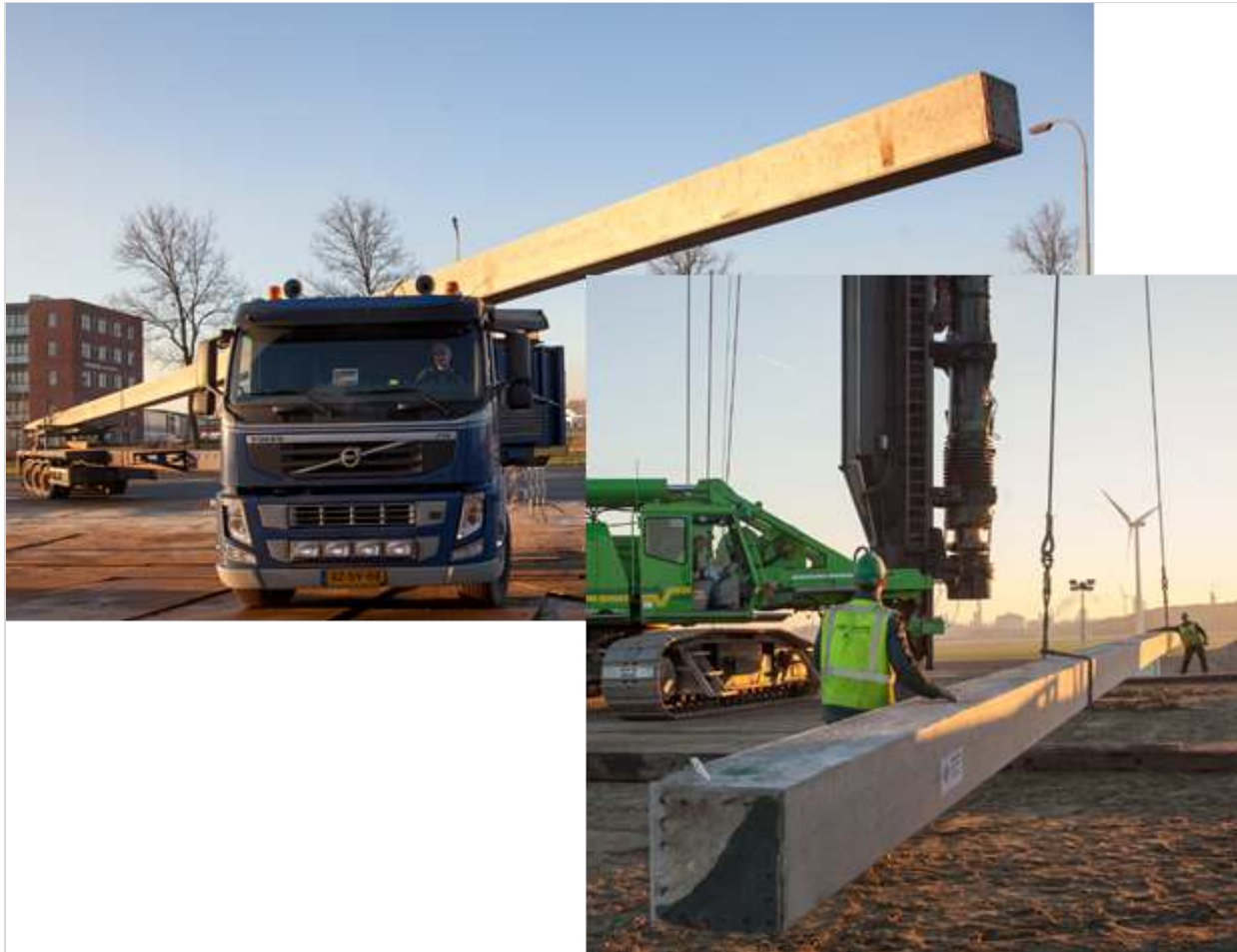
Figuur 622.1 - Transport en hijsen van prefab paal
