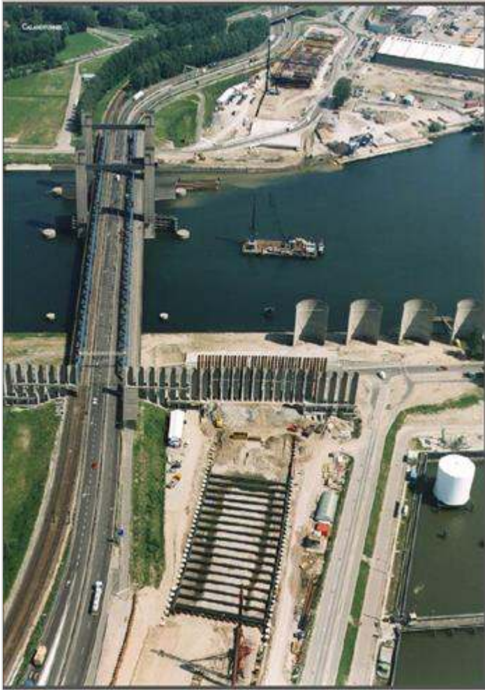
Figuur 126.1 - Bouwput Thomassentunnel
