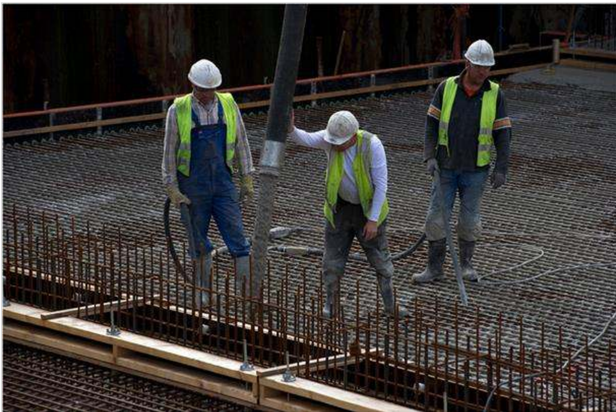
Figuur 654.1 - Betonstort
