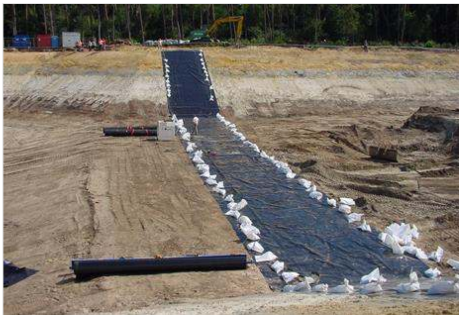
Figuur 188.2 - Eerste foliebaan in den droge gelegd
