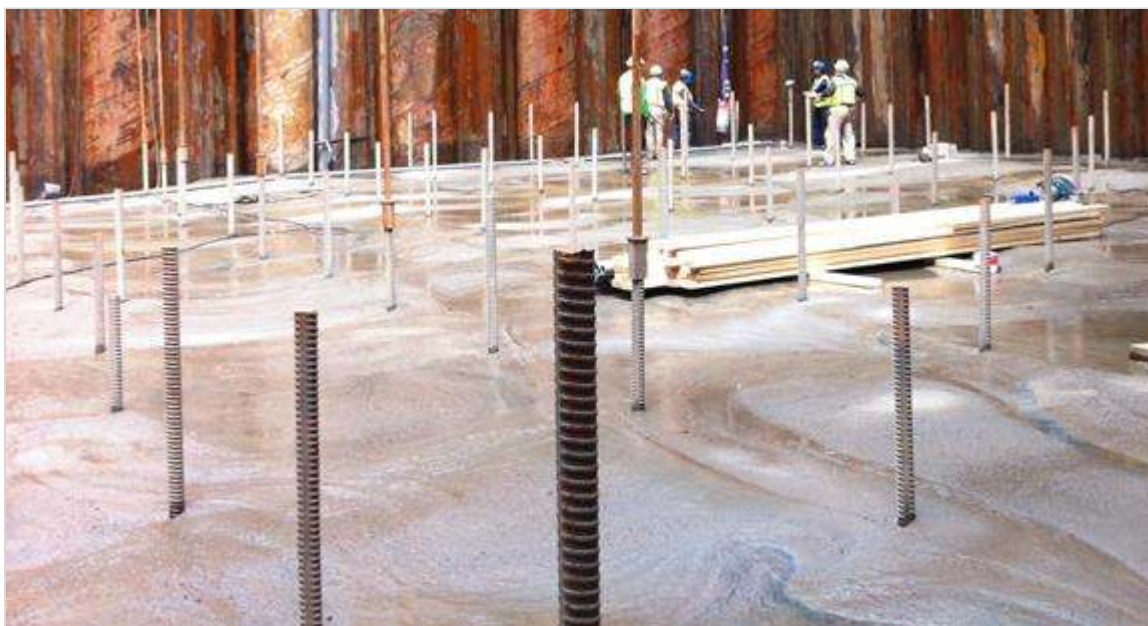
Figuur 638.1 - Onderwaterbetonvloer in bouwkuip
