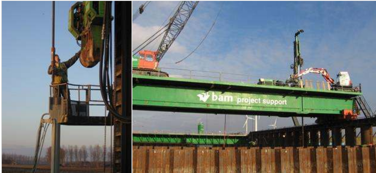
Figuur 623.2 - Inbrengen van GEWI palen vanaf traverse
