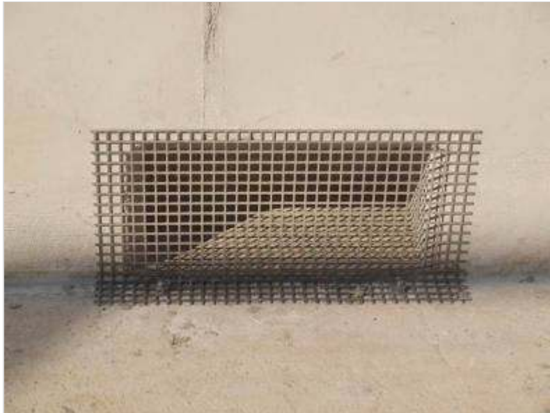
Figuur 398.2 - Rooster voor doorvoeropening in ballastbed
