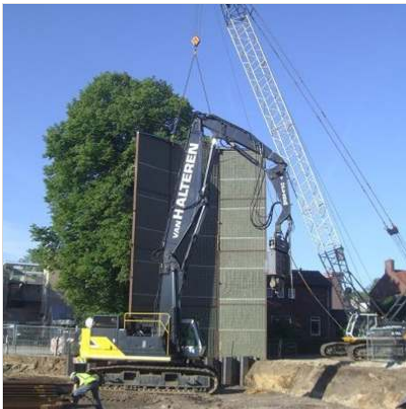
Figuur 143.1 - Mobiel geluidscherm bij bouw Combitunnel Nijverdal
