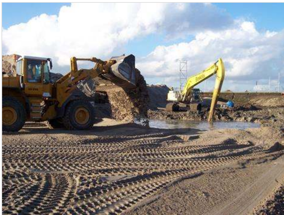
Figuur 596.1 - Droog ontgraven
