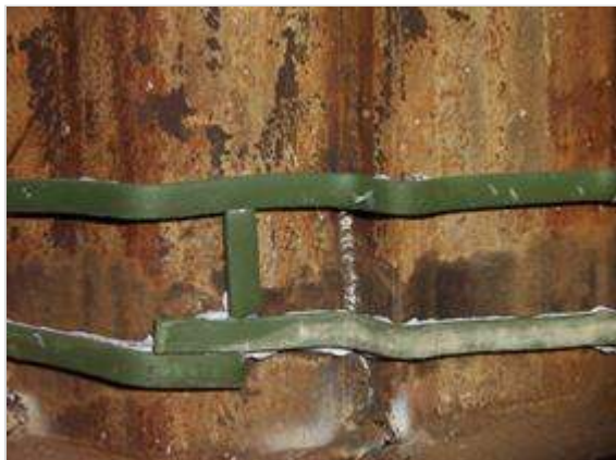
Figuur 272.1 - Voorbeeld van het compartimenten-systeem
