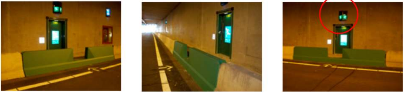
Figuur 378.1 - Locatie stepbarriers A2 Leidsche Rijntunnel
