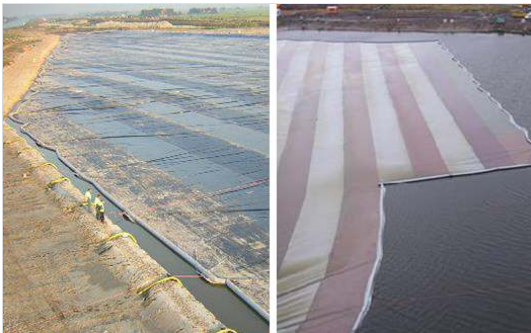
Figuur 193.1 - Afzinken folieconstructie met behulp van drijvers
