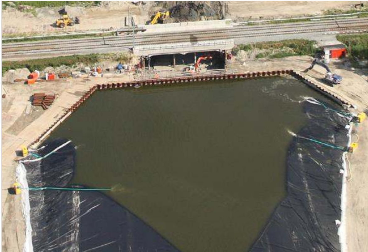
Figuur 588.1 - Afzinken folieconstructie
