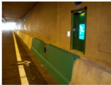
Figuur 378.1 - Locatie stepbarriers A2 Leidsche Rijntunnel
