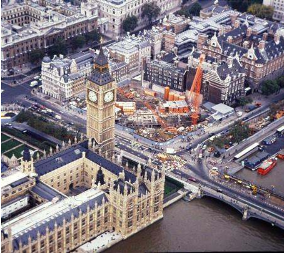
Figuur 129.1 - 39 m diepe bouwput naast een schadevrije BigBen [R. Mair; 2010]
