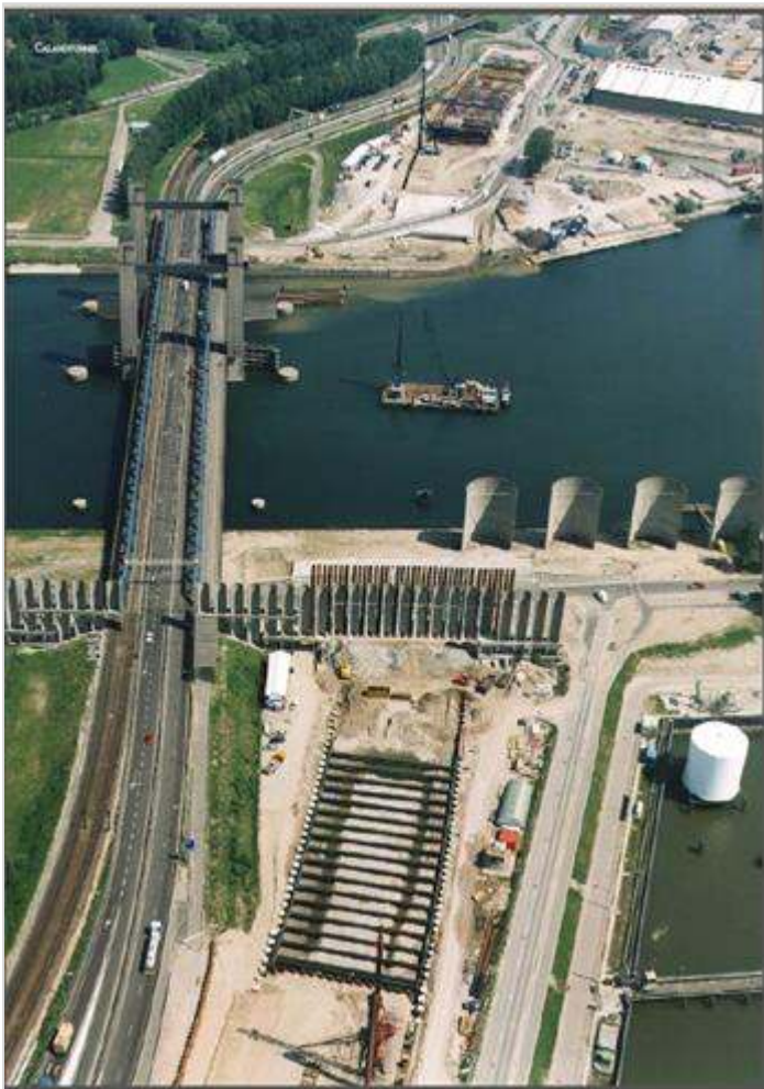
Figuur 126.1 - Bouwput Thomassentunnel
