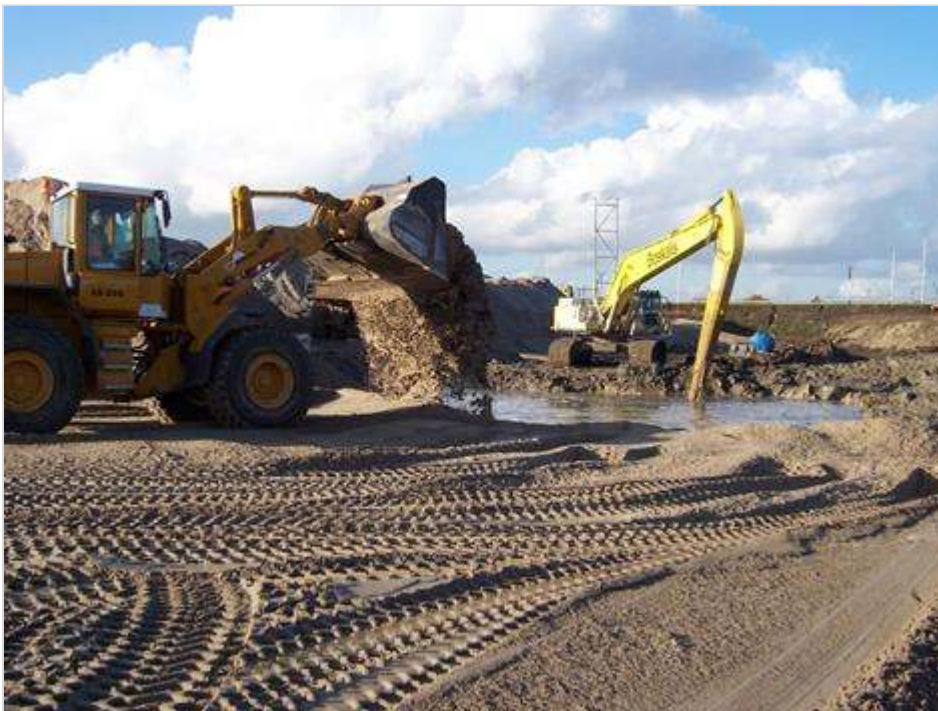
Figuur 596.1 - Droog ontgraven
