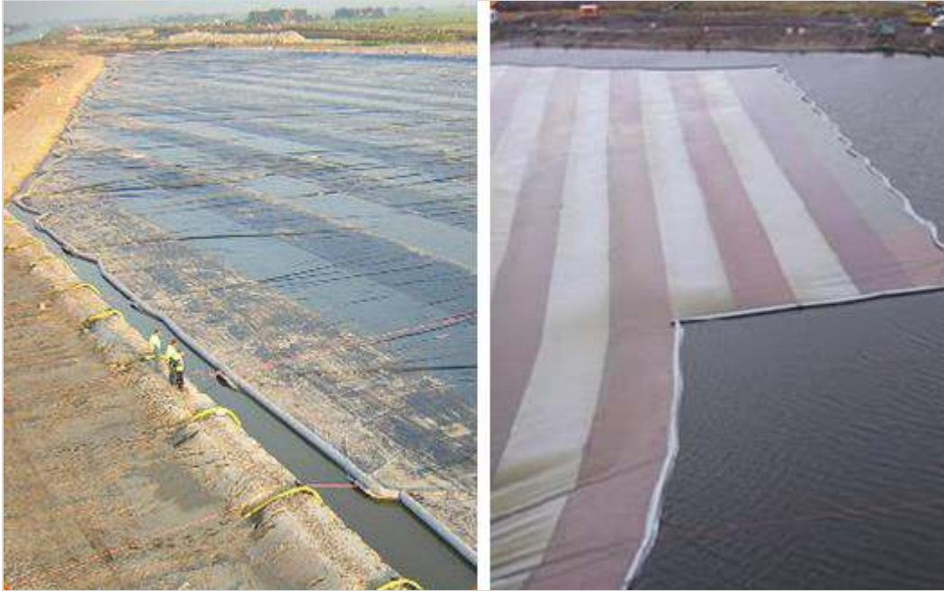
Figuur 193.1 - Afzinken folieconstructie met behulp van drijvers
