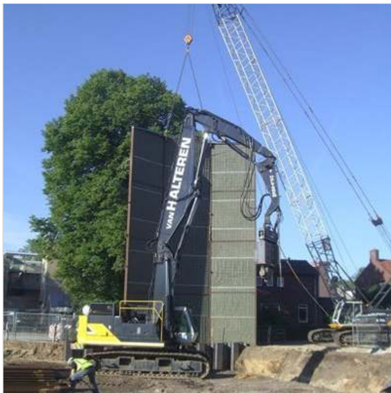
Figuur 143.1 - Mobiel geluidscherm bij bouw Combitunnel Nijverdal
