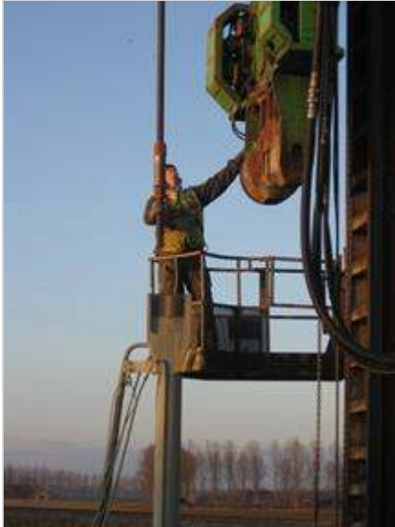
Figuur 623.2 - Inbrengen van GEWI palen vanaf traverse
