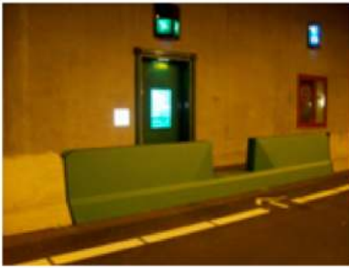
Figuur 378.1 - Locatie stepbarriers A2 Leidsche Rijntunnel
