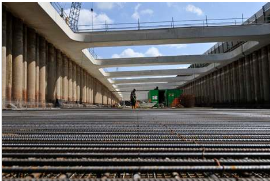
Figuur 73.1 - Permanente stempels bij verdiepte ligging A4 te Leiderdorp (bouwphase)
