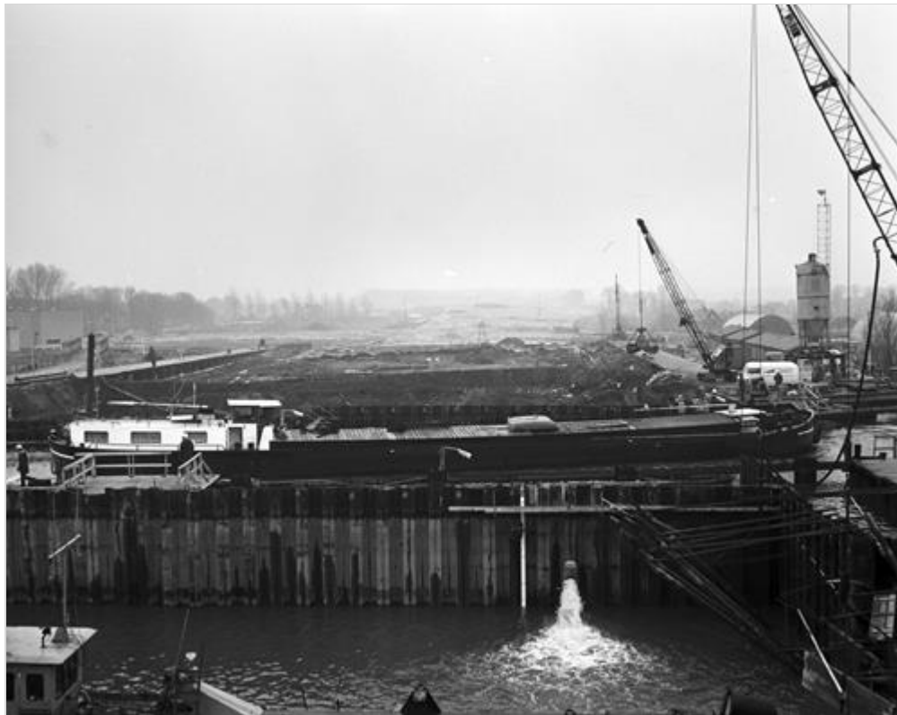
Figuur 213.4 - Bouw van Gouweaquaduct
