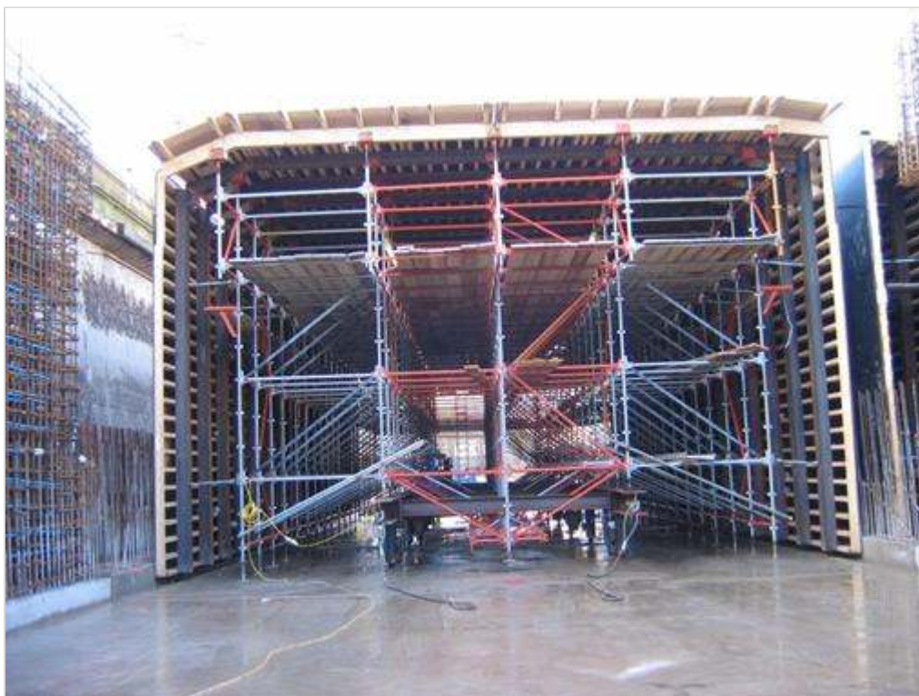
Figuur 652.1 - Voorbeeld houten tunnelkist
