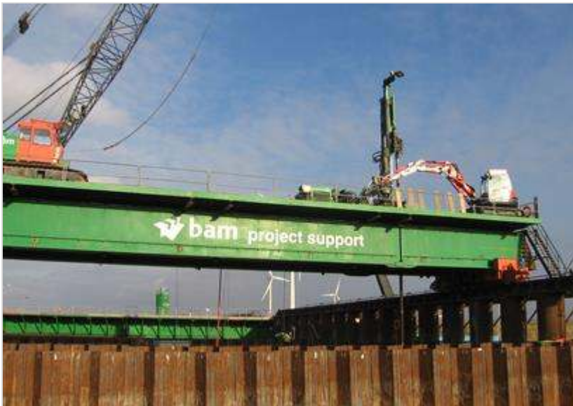
Figuur 623.2 – Inbrengen van GEWI palen vanaf traverse
