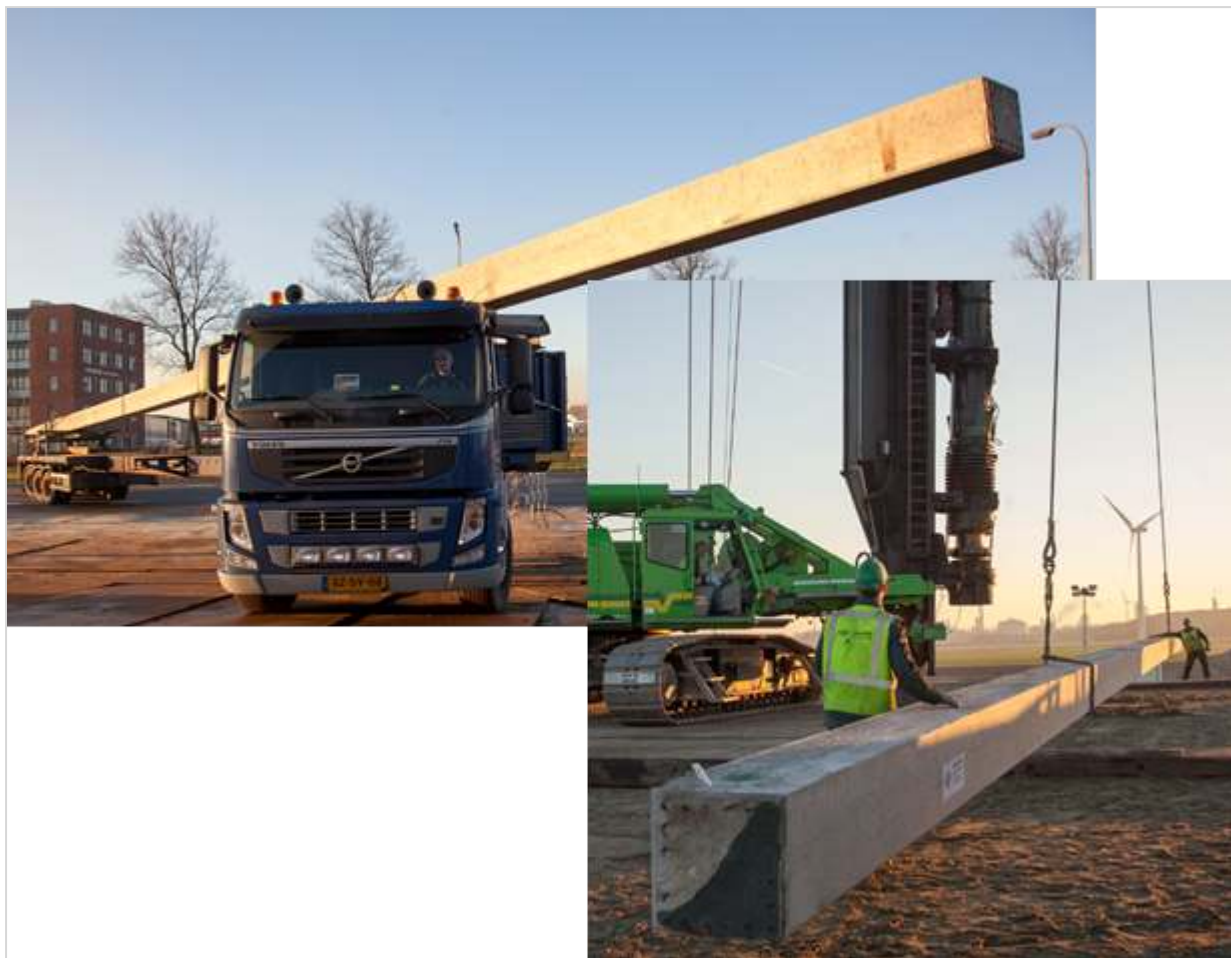
Figuur 622.1 - Transport en hijsen van prefab paal
