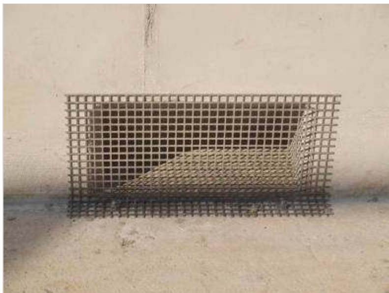
Figuur 398.2 - Rooster voor doorvoeropening in ballastbed
