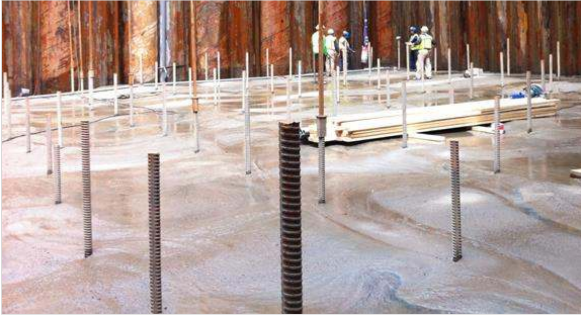
Figuur 638.1 - Onderwaterbetonvloer in bouwkuip
