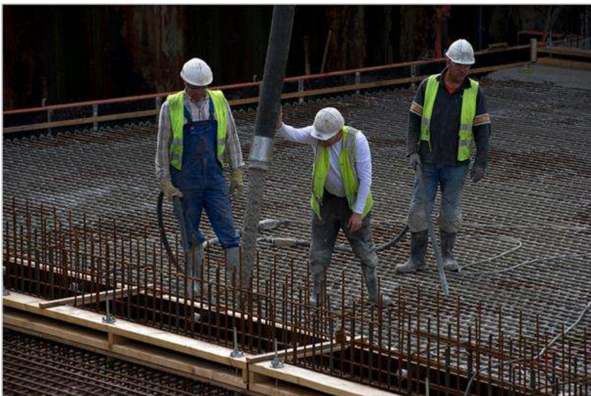
Figuur 654.1 - Betonstort
