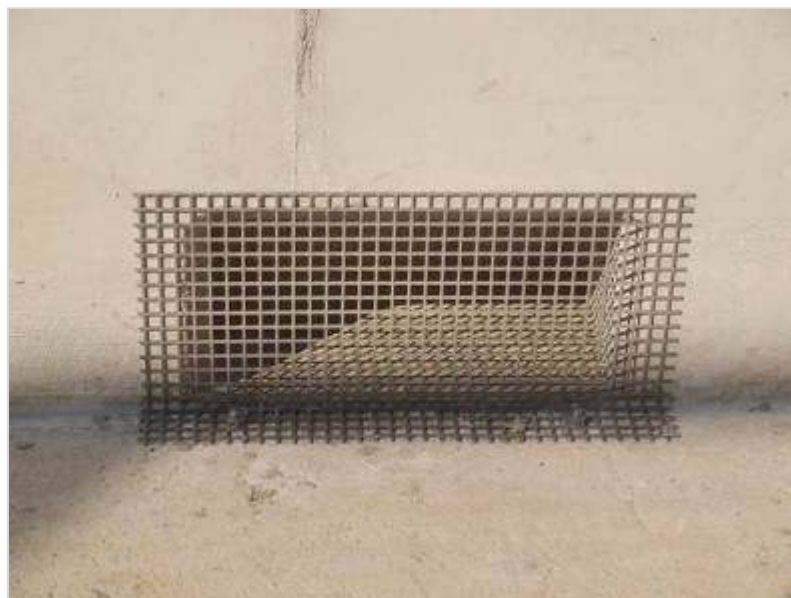
Figuur 398.2 - Rooster voor doorvoeropening in ballastbed
