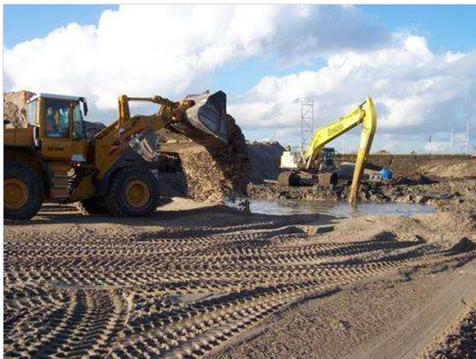
Figuur 596.1 - Droog ontgraven
