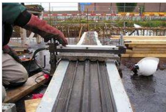
Figuur 93.3 - Voorbeeld van vulcanisatie met matrijs en vulcanisatie-apparaat
