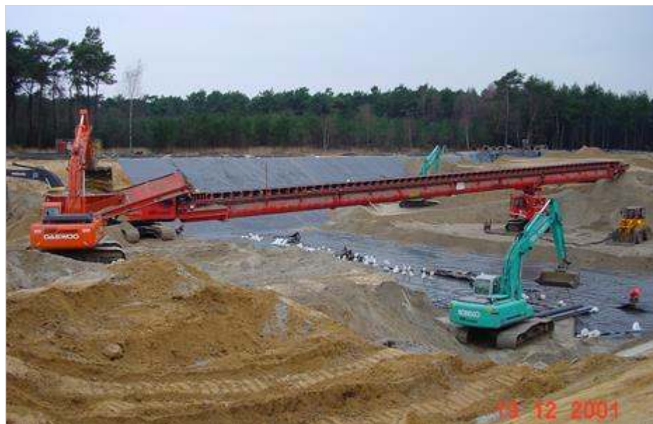
Figuur 188.3 - Afdekken folieconstructie
