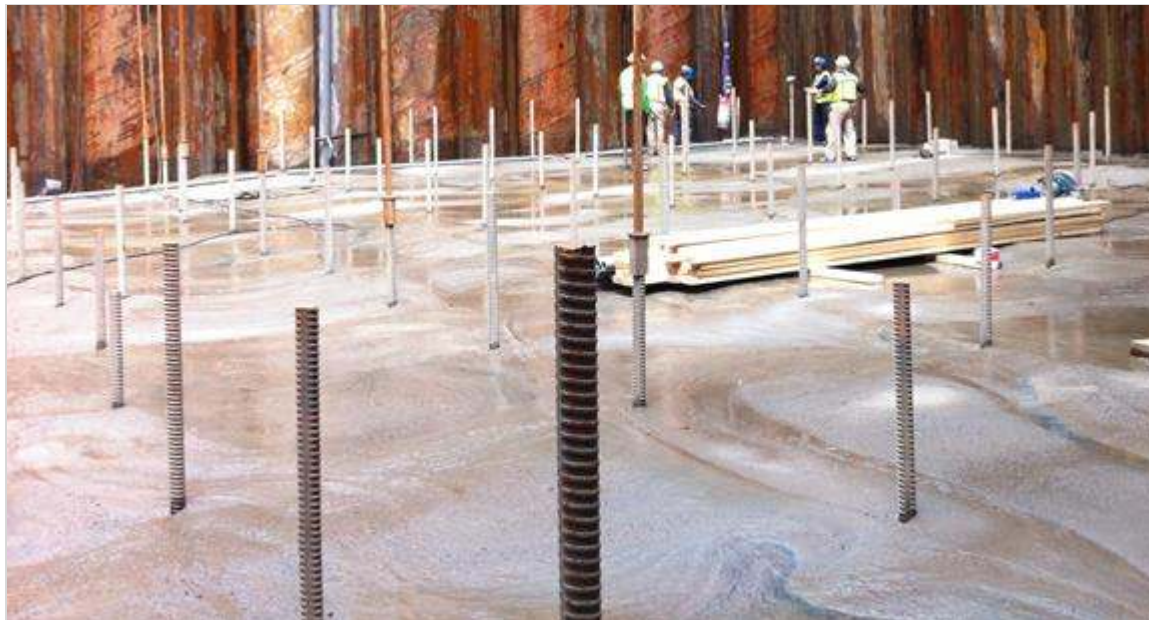
Figuur 638.1 - Onderwaterbetonvloer in bouwkuip
