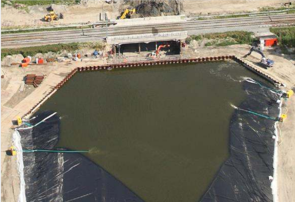
Figuur 588.1 - Afzinken folieconstructie
