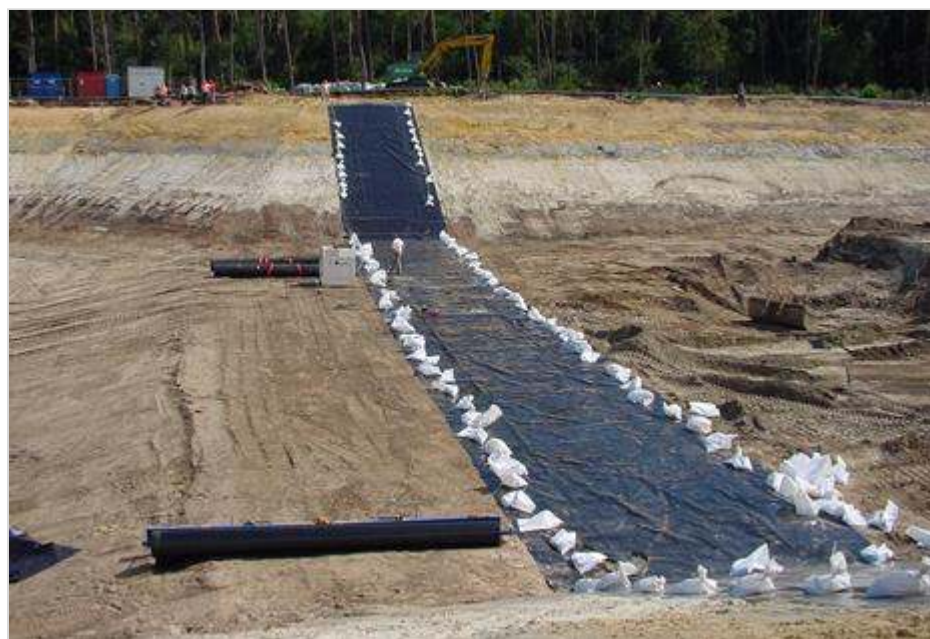
Figuur 188.2 - Eerste foliebaan in den droge gelegd
