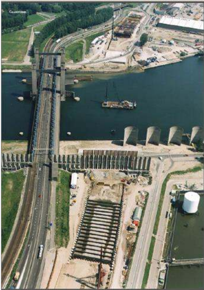
Figuur 126.1 - Bouwput Thomassentunnel
