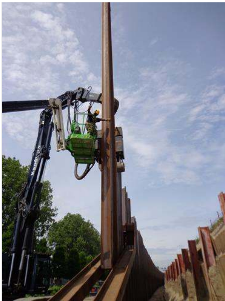
Figuur 541.1 - Voorbeeld aanbrengen van damwanden
