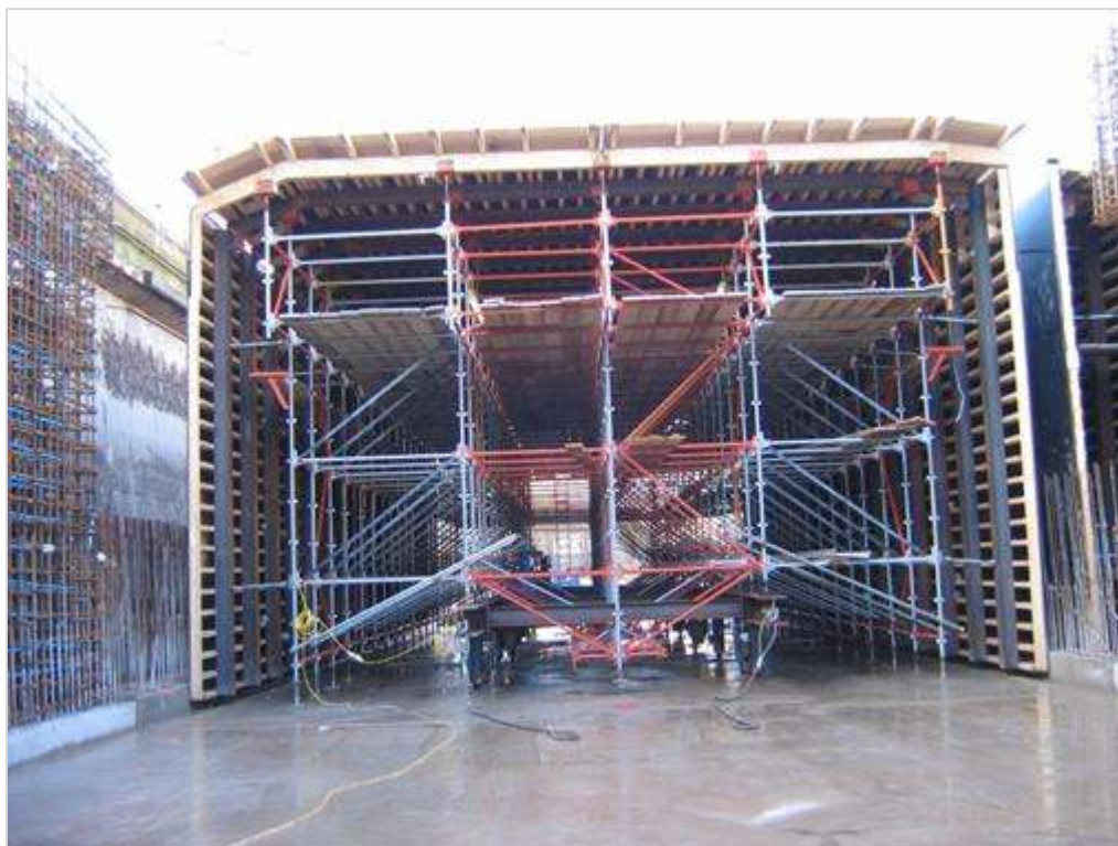
Figuur 652.1 - Voorbeeld houten tunnelkist
