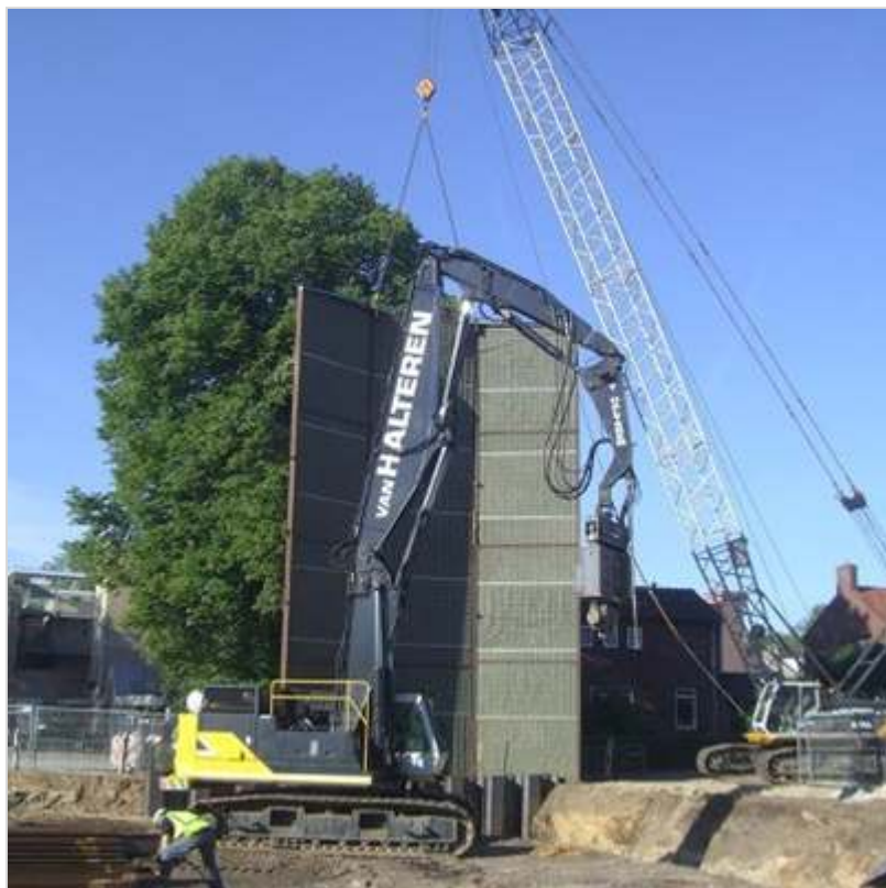
Figuur 143.1 - Mobiel geluidsscherm bij bouw Combitunnel Nijverdal
