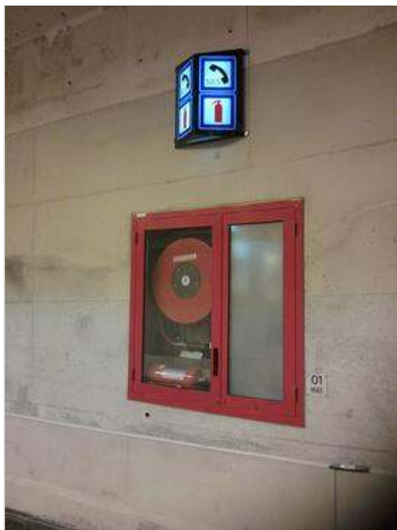
Figuur 461.3 - Hulpkast type 1
