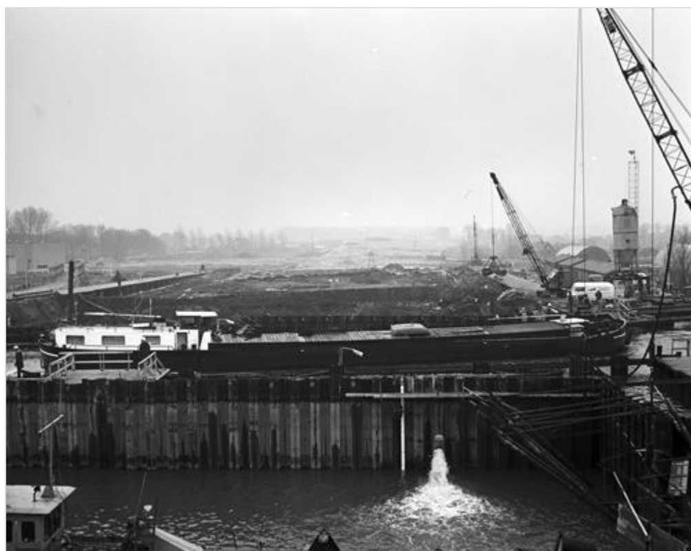
Figuur 213.4 - Bouw van Gouweaqueduct
