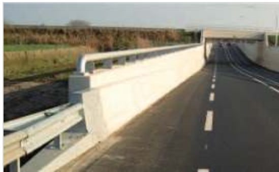
Figuur 458.4 - Foto 3 overgang stepbarrier geleiderail
