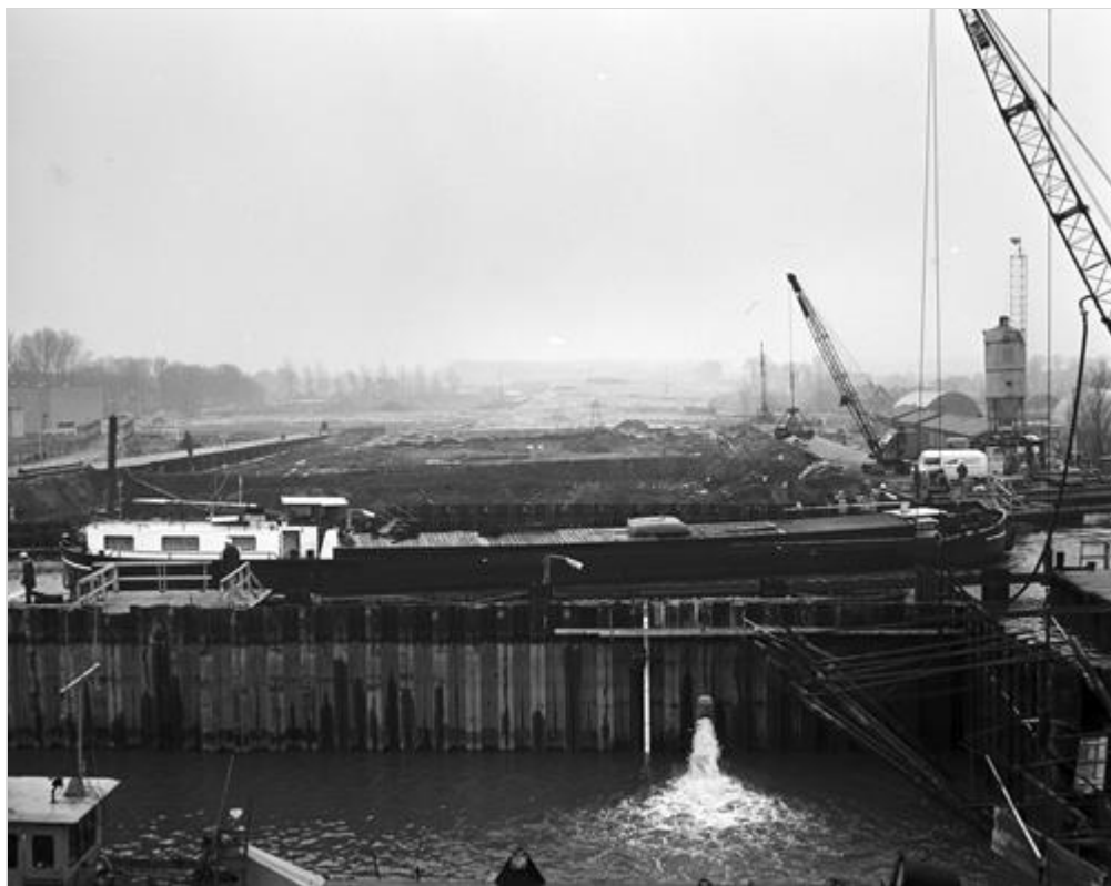
Figuur 213.4 - Bouw van Gouweaqueduct
