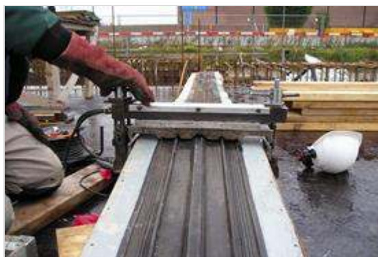
Figuur 93.3 - Voorbeeld van vulkanisatie met matrijs en vulkanisatie-apparaat
