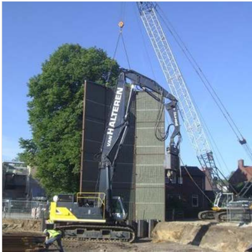
Figuur 143.1 - Mobiel geluidsscherm bij bouw Combitunnel Nijverdal
