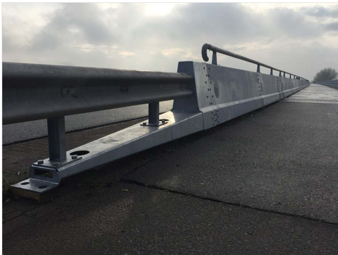
Figuur 458.3 - Foto 2 overgang stepbarrier geleiderail
