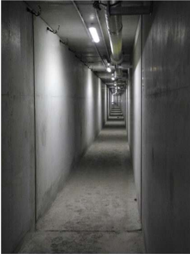
Foto 1: Vluchtgang, vloer dienstgang van prefab betonplaten
