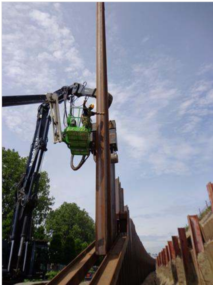
Figuur 541.1 - Voorbeeld aanbrengen van damwanden
