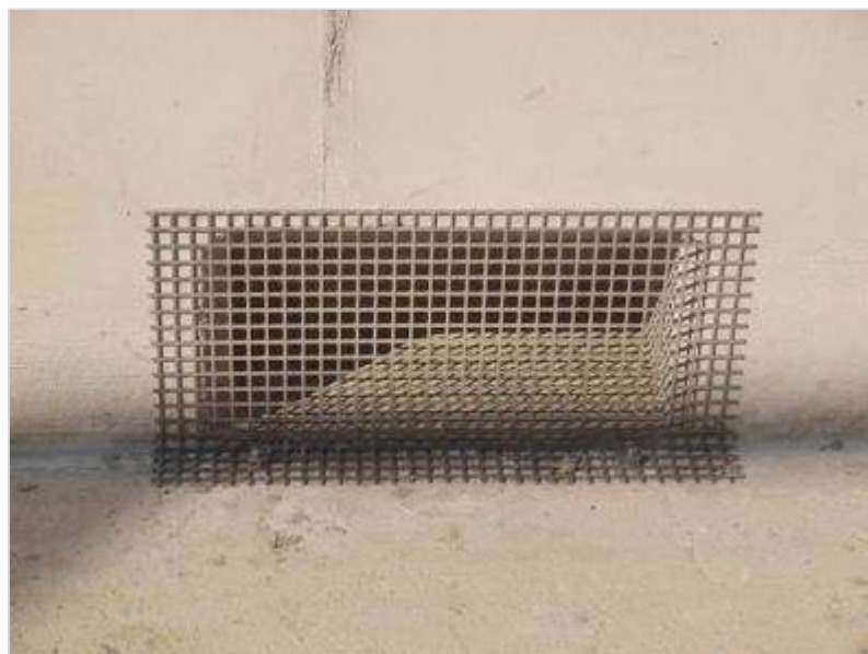
Figuur 398.1 - Afvoergoot onder vlucht/inspectiepad
