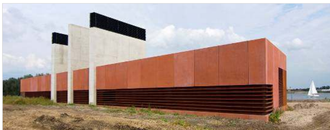
Figuur 446.1 - Dienstgebouw Drontermeertunnel
