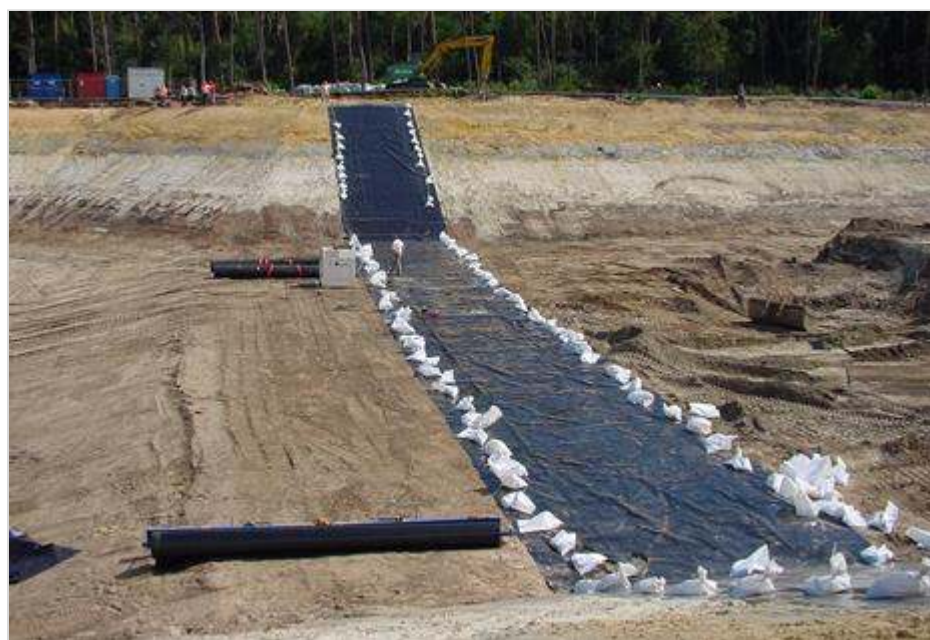
Figuur 188.2 - Eerste foliebaan in den droge gelegd
