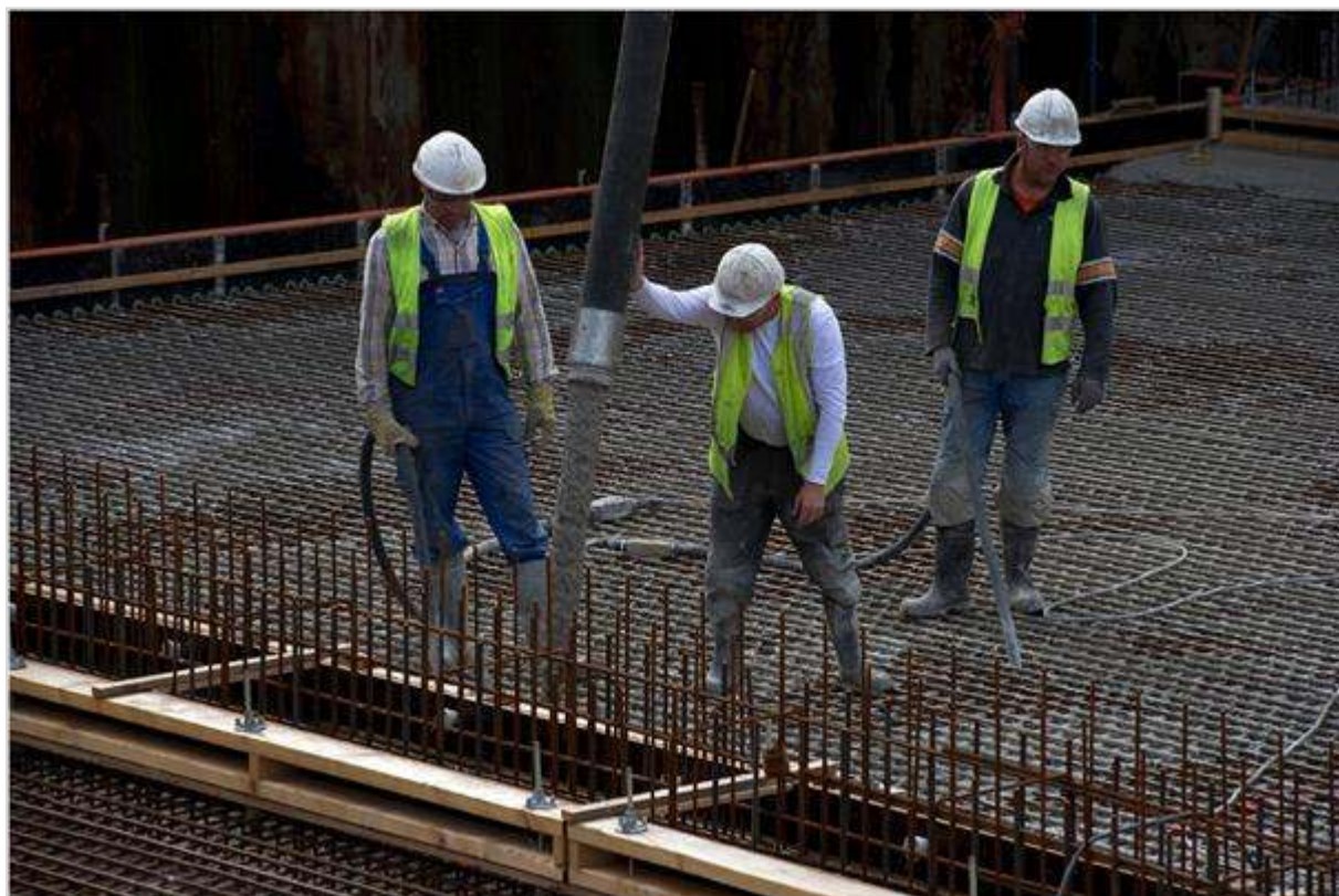
Figuur 654.1 - Betonstort
