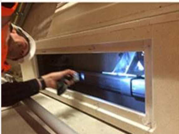
Foto 10: Onderhoudsdeur typ rail en ophanging vloerdeur
