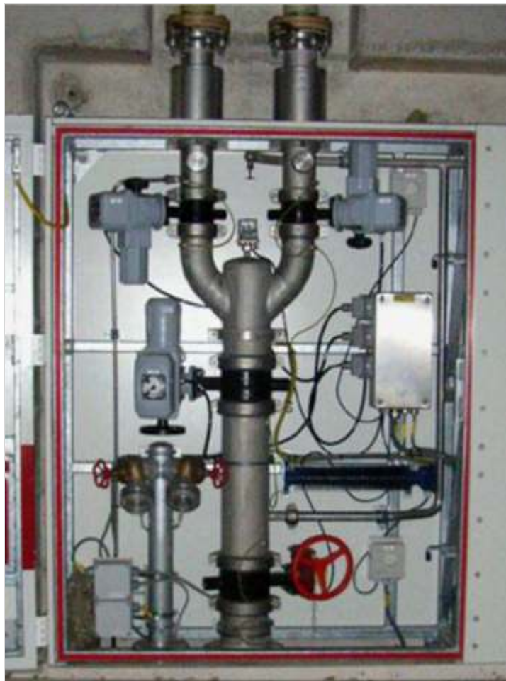
Figuur 279.1 - Voorbeeld inkassing ten behoeve van droge blusleiding
