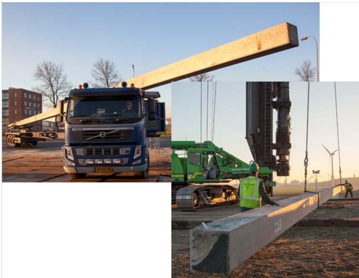
Figuur 622.1 - Transport en hijsen van prefab paal
