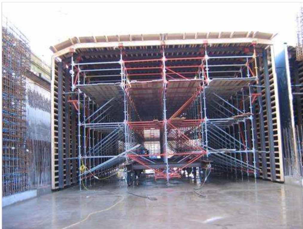
Figuur 652.1 - Voorbeeld houten tunnelkist
