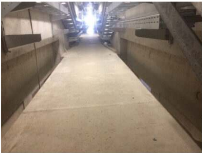
Foto 3: Vloer kabelgang met "brievenbussen" voor ophanging vluchtdeuren
