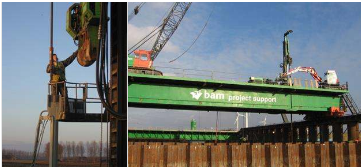
Figuur 623.2 - Inbrengen van GEWI palen vanaf traverse
