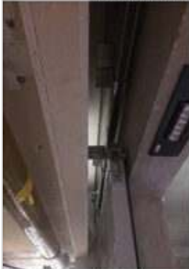
Foto 6: Hwb tegen onderzijde vloer en om de stalen draagbalk
