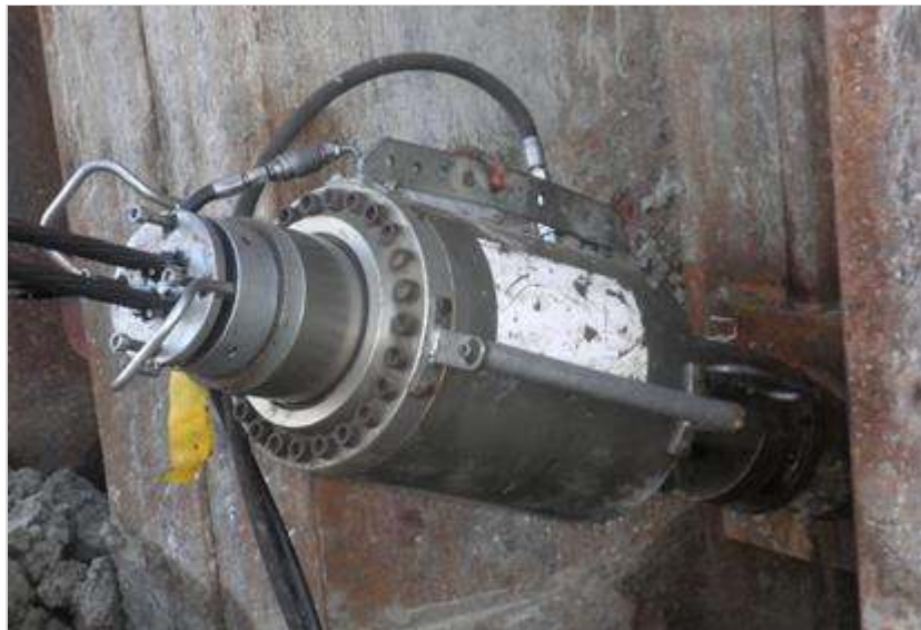
Figuur 576.1 - Testen groutanker
