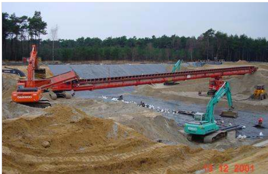
Figuur 188.3 - Afdekken folieconstructie
