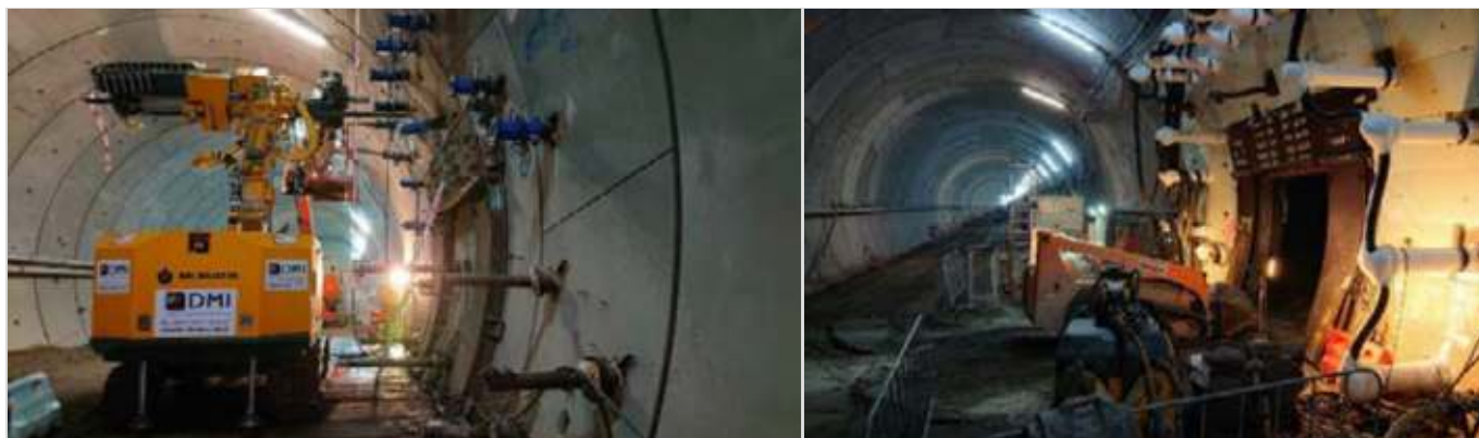
Figuur 690.11 - Voorbeeld van aanbrengen vrieslanzen en ontgraven dwarsverbinding. (Foto's: Joost Vervoort/Arthe Civil & Structure)
