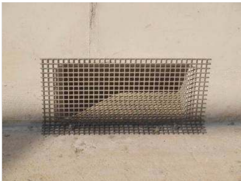
Figuur 398.2 - Rooster voor doorvoeropening in ballastbed
