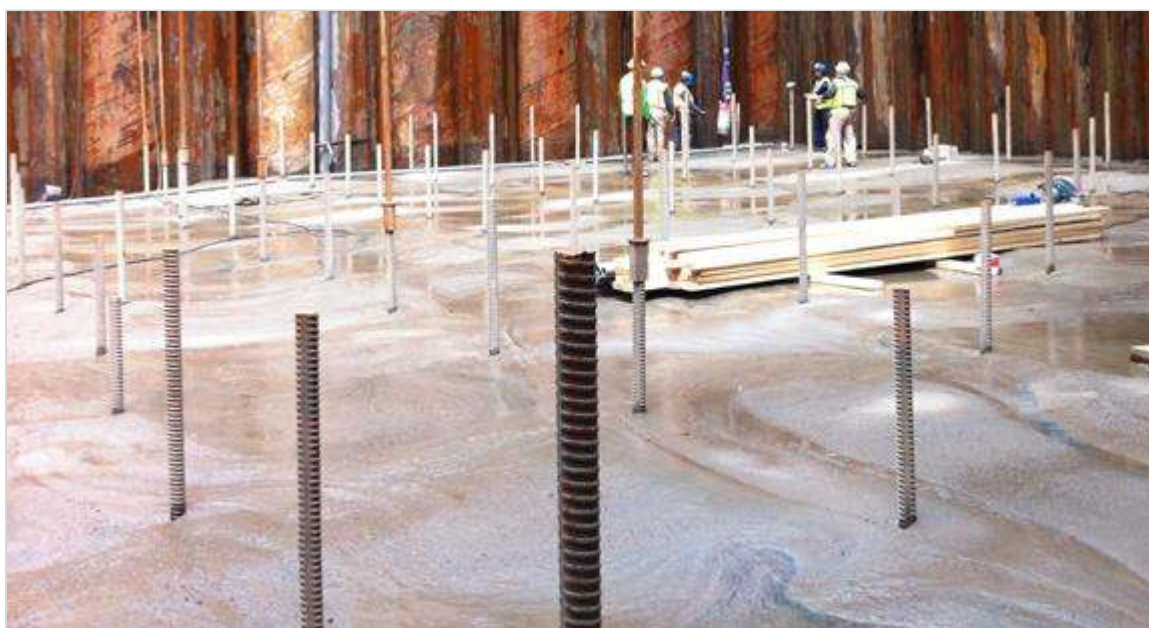
Figuur 638.1 - Onderwaterbetonvloer in bouwkuip
