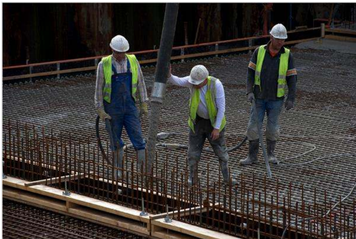
Figuur 654.1 - Betonstort
