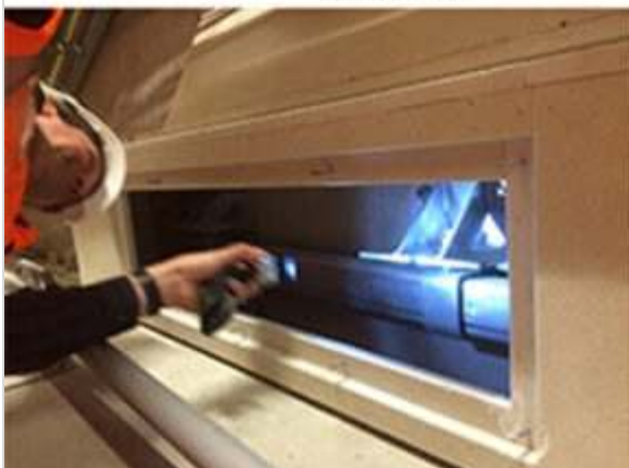
Foto 10: Onderhoudsdoek typ rail en ophanging vloerdeur.
