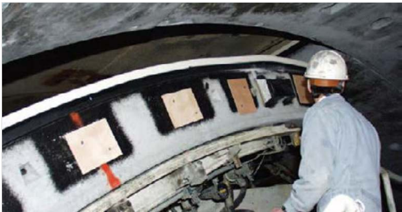
Figuur 690.17 - Voorbeeld van kom-nokverbinding. (Foto: N.V. Westerscheldetunnel)
