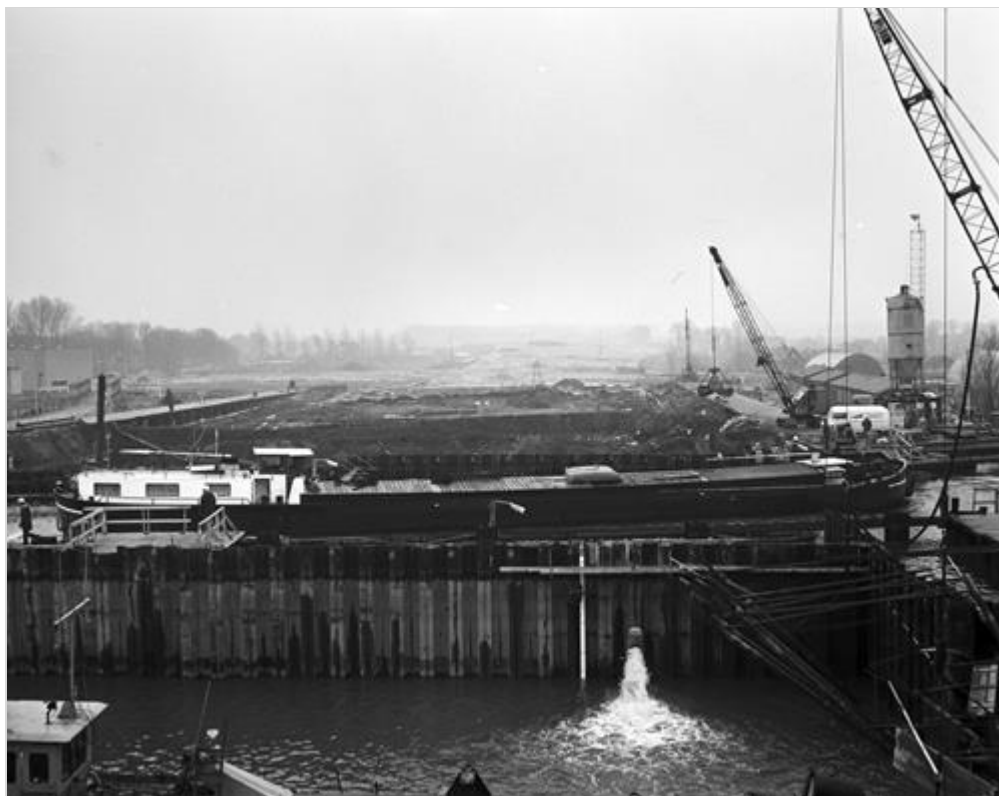
Figuur 213.4 - Bouw van Gouweaquaduct
