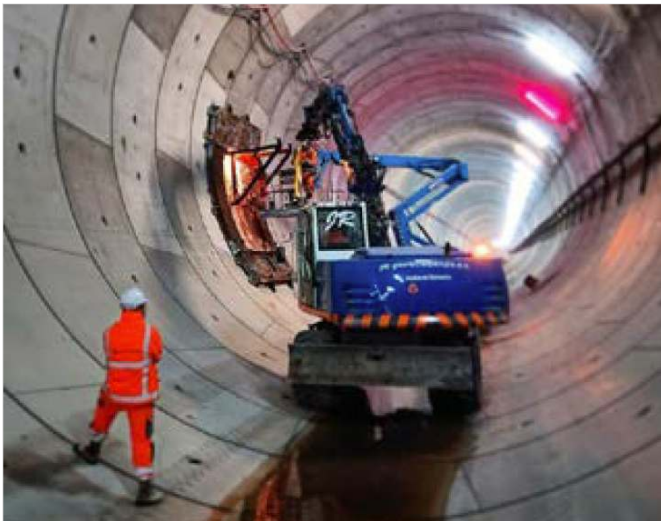
Figuur 690. 12 - Voorbeeld van plaatsing stalen frame. (Foto: Joost Vervoort/Arthe Civil & Structure)
