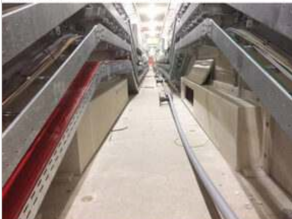
Foto 8: Hwb omlijstingen typ 'trievenbussen' door de vloer dienstgang.
