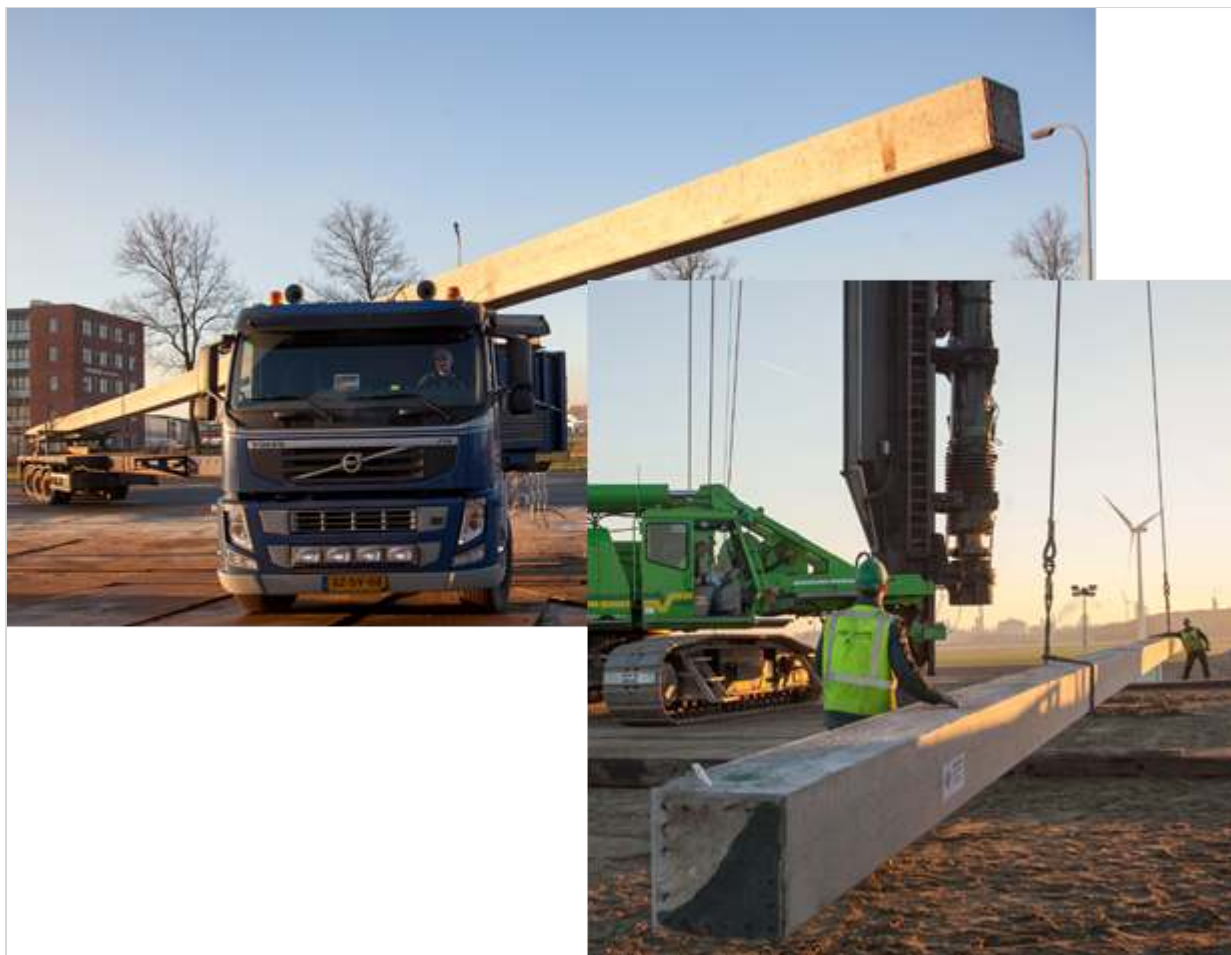
Figuur 622.1 - Transport en hijsen van prefab paal
