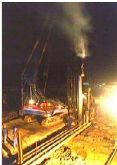
Figuur 157.1 - Nachtelijk heiwerk van damwandplanken [ https://beeldbank.rws.nl , Rijkswaterstaat / Rens Jacobs]
