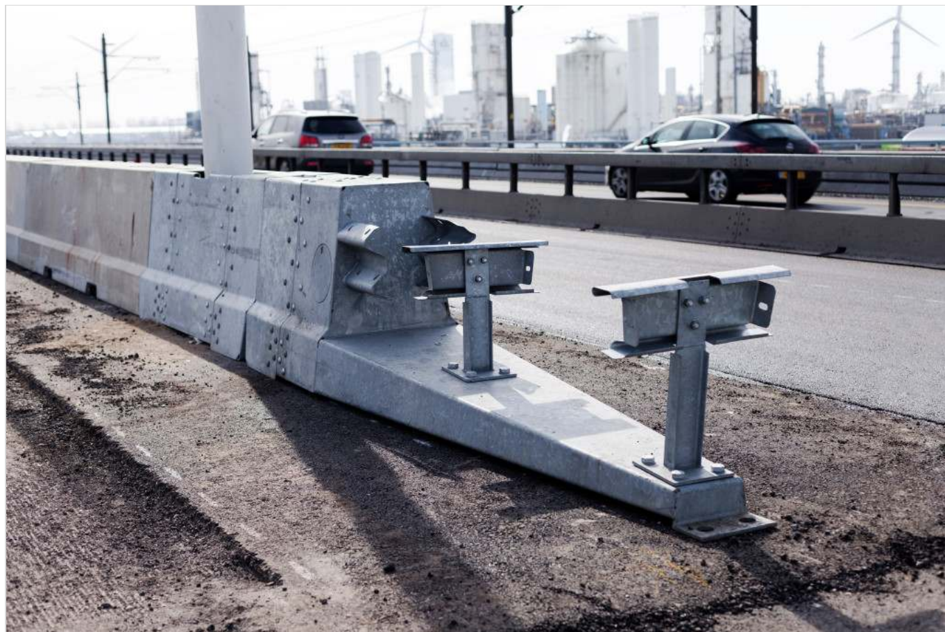
Figuur 458.2 - Foto 1 overgang stepbarrier geleiderail
