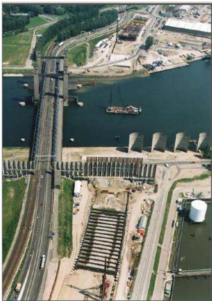
Figuur 126.1 - Bouwput Thomassentunnel
