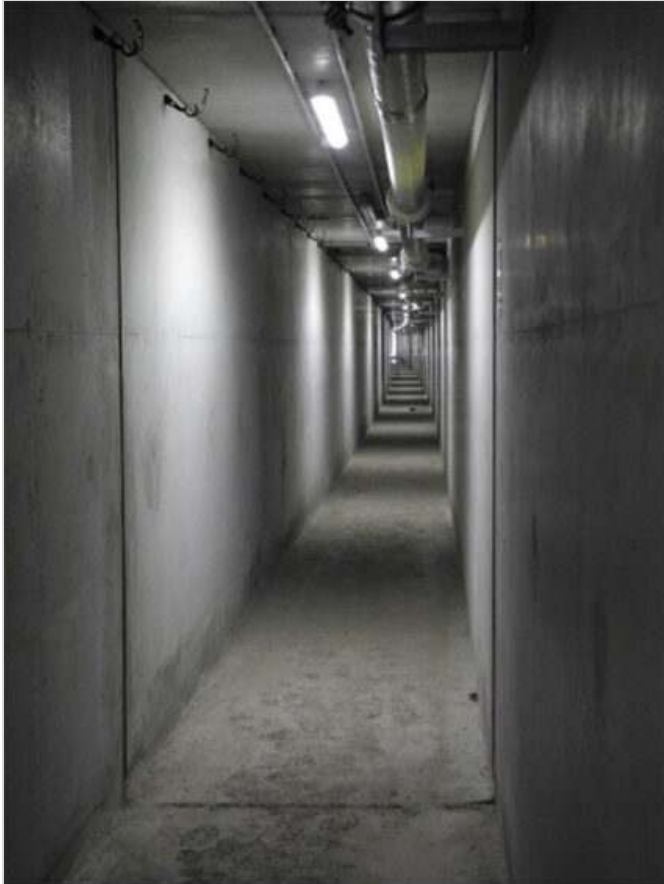
Foto 1: Vluchtgang, vloer dienstgang van prefab betonplaten
