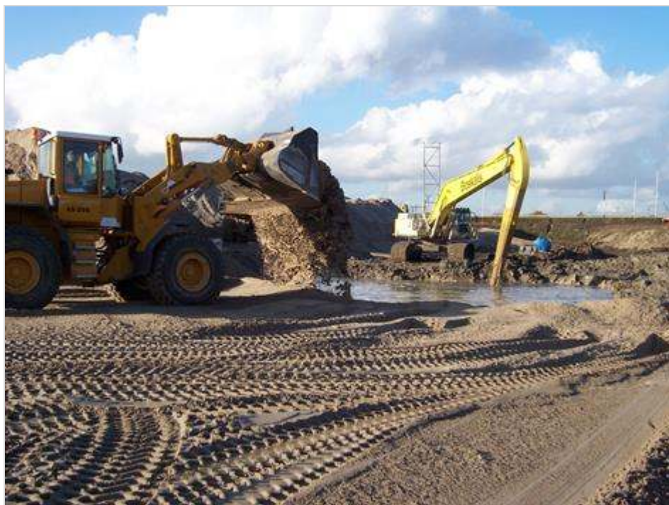
Figuur 596.1 - Droog ontgraven
