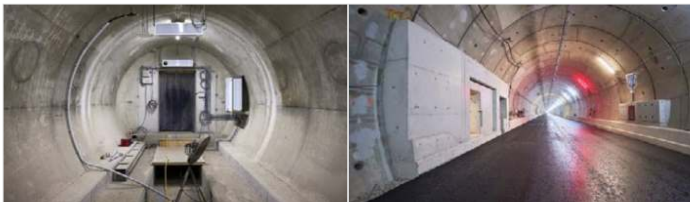
Figuur 690.13 - Voorbeeld van afwerking binnen- en buitenzijde dwarsverbinding. (Foto's: RijnlandRoute)
