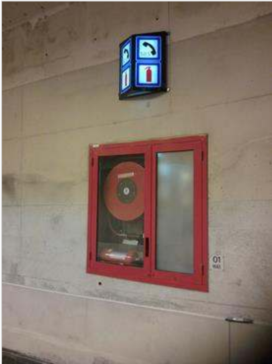
Figuur 461.3 - Grote hulppost (type A)
