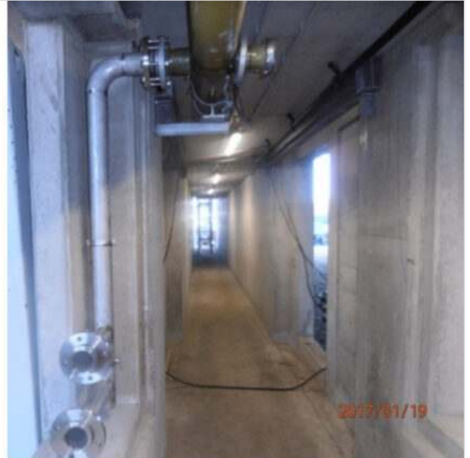
Foto 2: Rechts vluchtdeur sparing en stalen draagbalk vloer dienstgang
