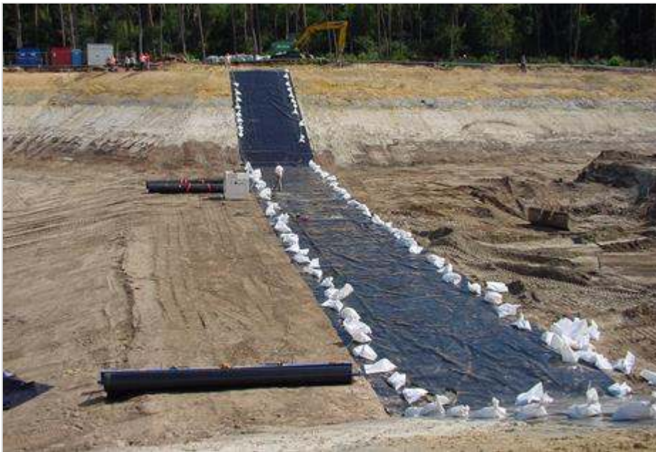
Figuur 188.2 - Eerste foliebaan in den droge gelegd
