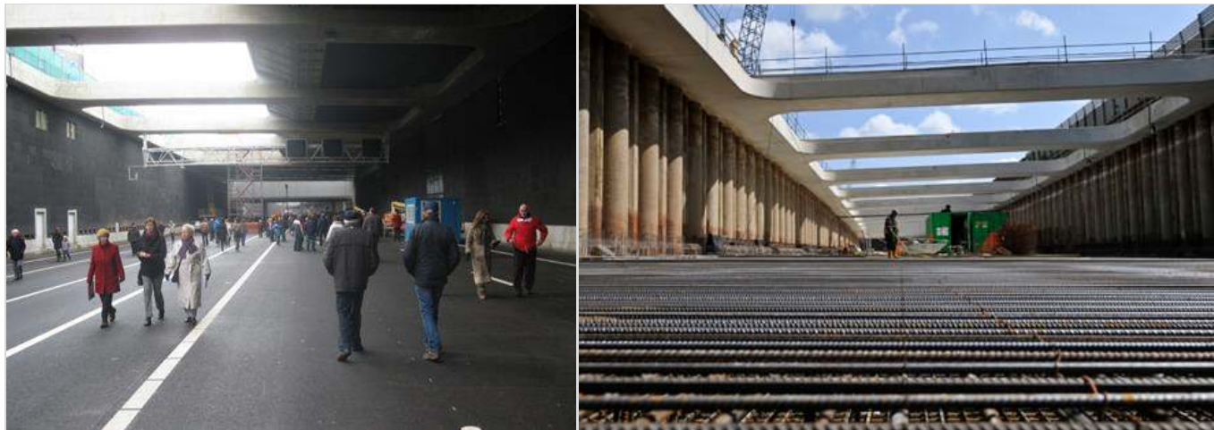
Figuur 73.1 - Permanente stempels bij verdiepte ligging A4 te Leiderdorp (bouwphase)
