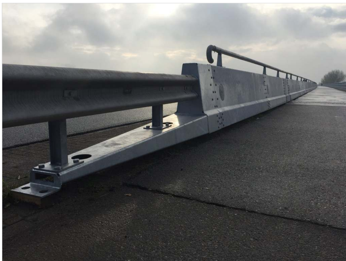
Figuur 458.3 - Foto 2 overgang stepbarrier geleiderail
