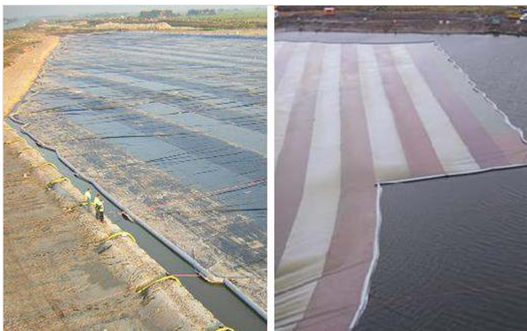
Figuur 193.1 - Afzinken folieconstructie met behulp van drijvers
